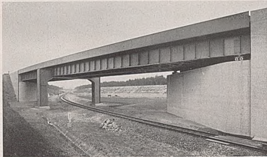
Abb. 7. Kreuzungsbauwerk 3a im Reichsparteitagsgelände.
