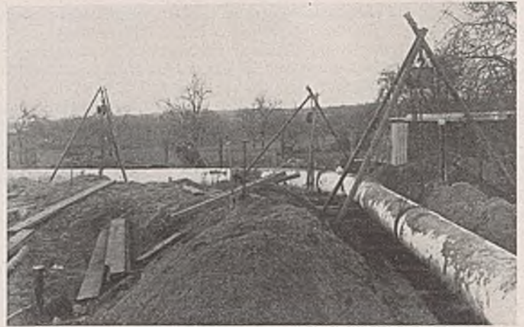
Abb. 4. Verlegung eines Krümmerstranges.
