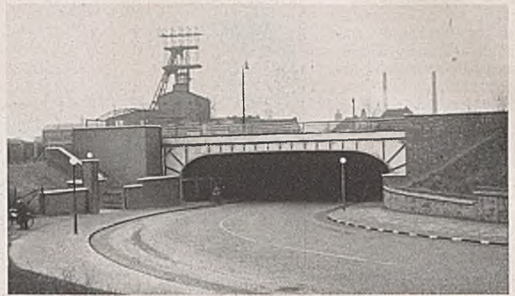
Abb. 9. Unterführung der Concordia-Straße in Oberhausen.
