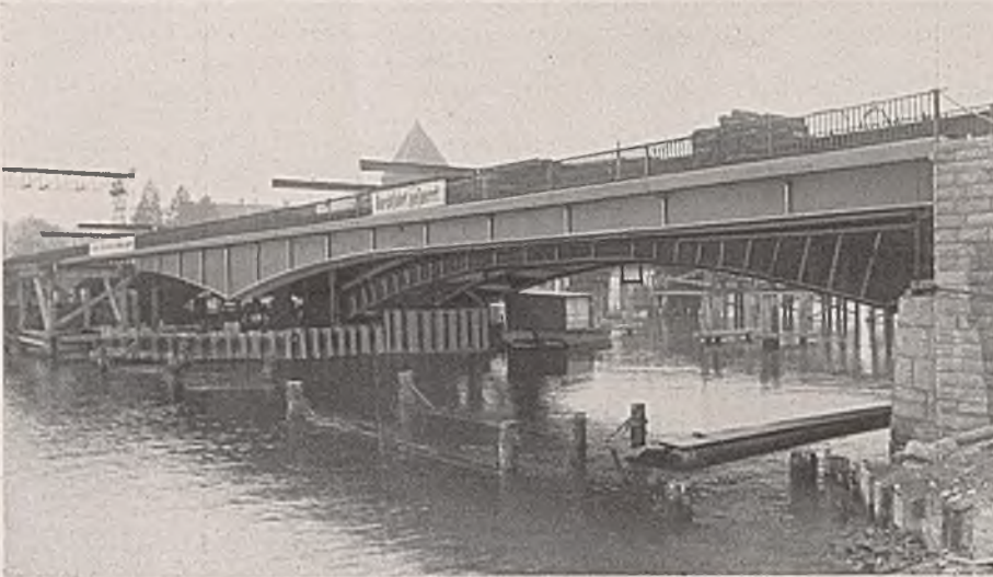
Abb. 12. Rheinbrücke in Konstanz. Seitenöffnung.
