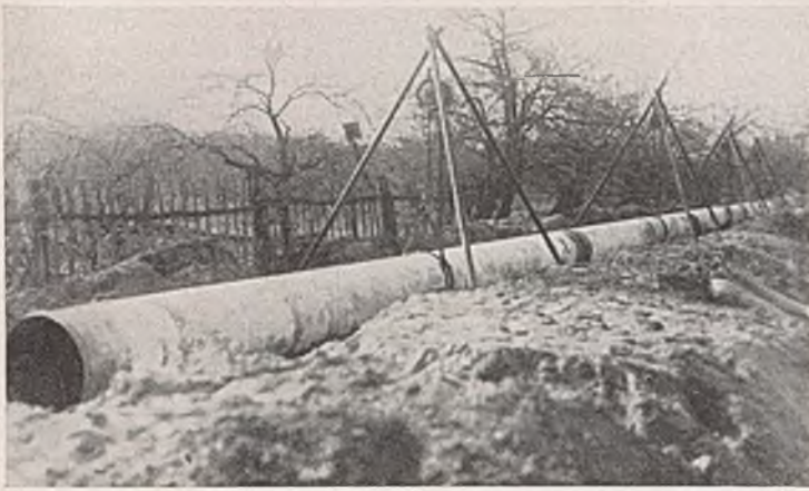
Abb. 3. Verlegung eines 40-m-Stoßes.
