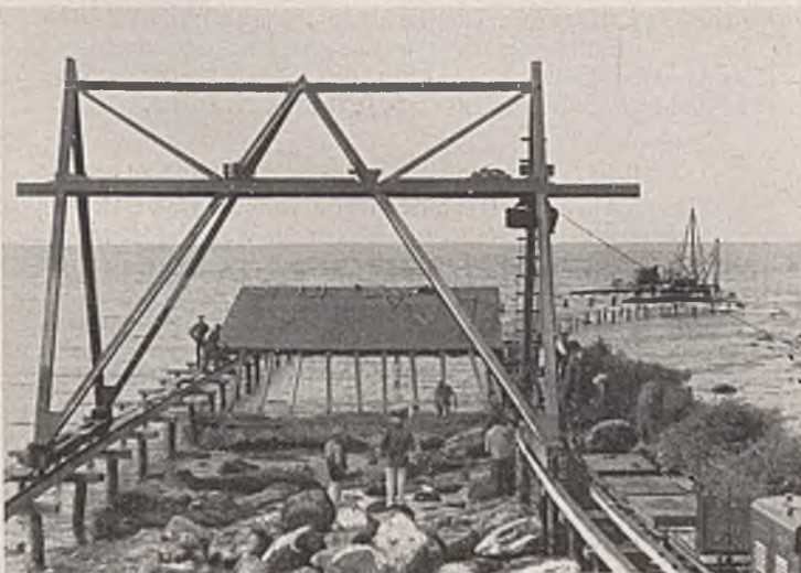
Abb. 8. Bau des Steindammes vor der Hücke am Steilufer Hiddensee. Hinten Gerüststramme, davor Faschinenbühne und Steinversetzkran.
