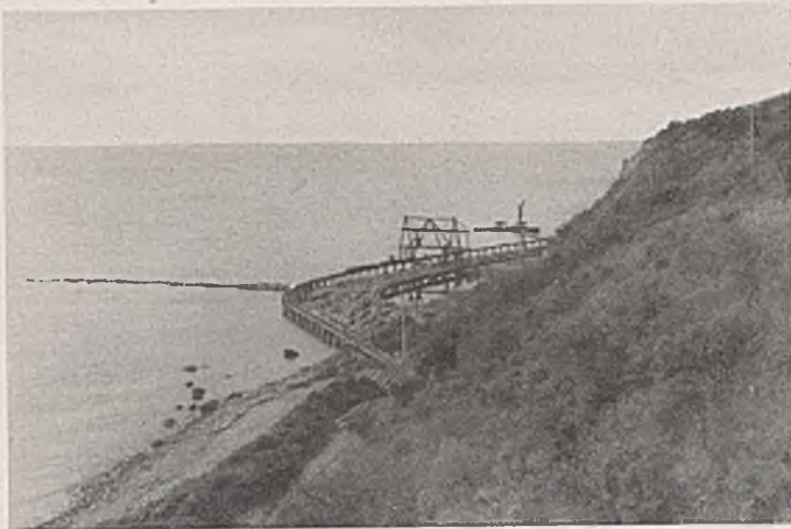
Abb. 7. Bau des Steindammes an der Hücke am Steilufer Hiddensee.
