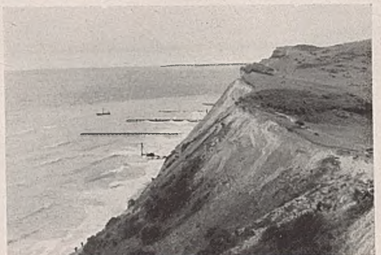
Abb. 6. Bau der Stahlpundwandbühnen vor dem Steilufer von Hiddensee.
