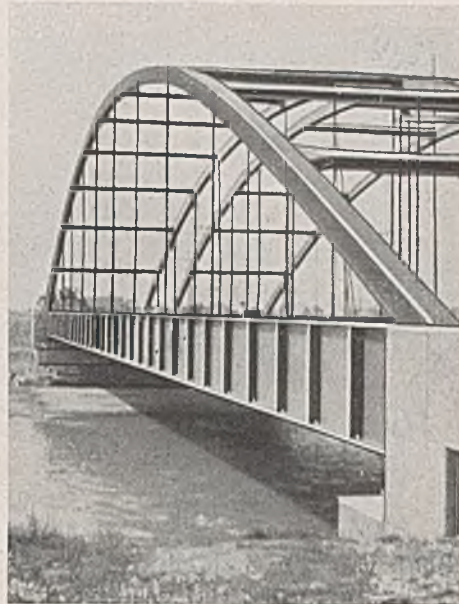
Abb. 15. Seitenansicht der fertigen Brücke.
