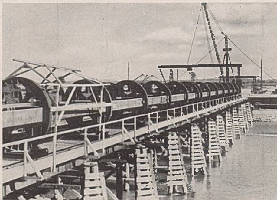
Abb. 3. Seitenansicht des Montagegerüsts mit Drehvorrichtung.
