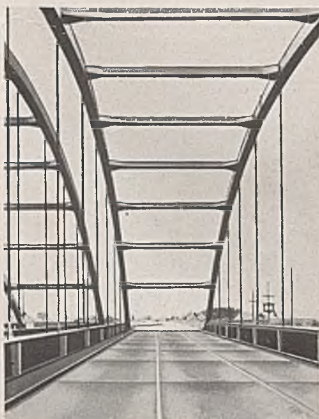
Abb. 6. Durchsicht durch die Brücke mit Stabbogen, Querriegel und Hängestangen.
