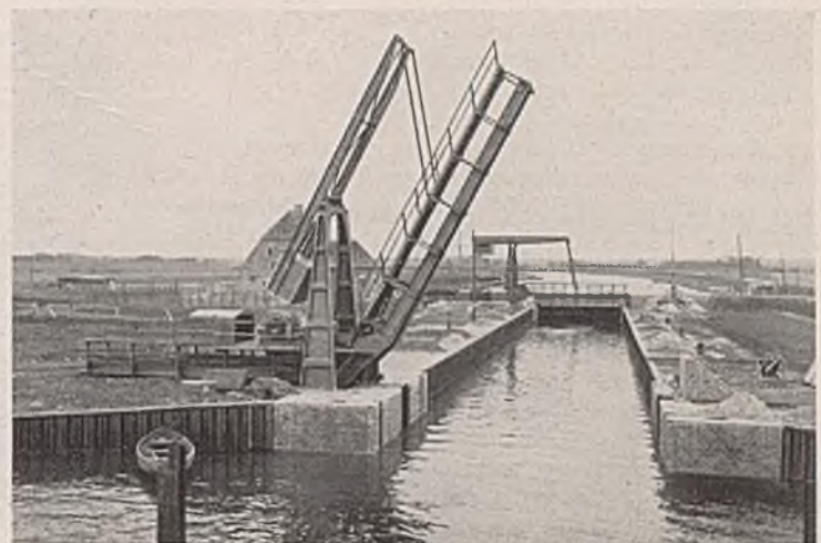
Abb. 10. Verbindungsschleuse im Gieselaukanal von der Eiderseite gesehen.
