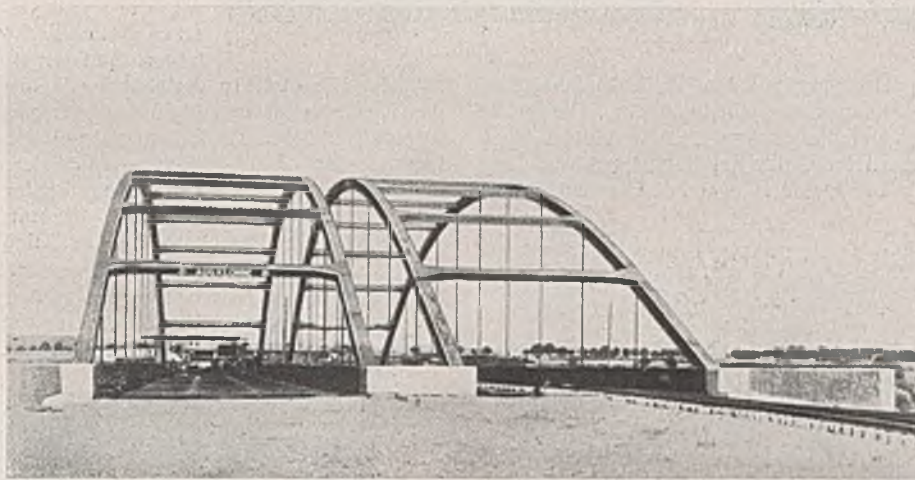
Abb. 17. Ansicht der fertigen Brücke von der Autobahn aus.
