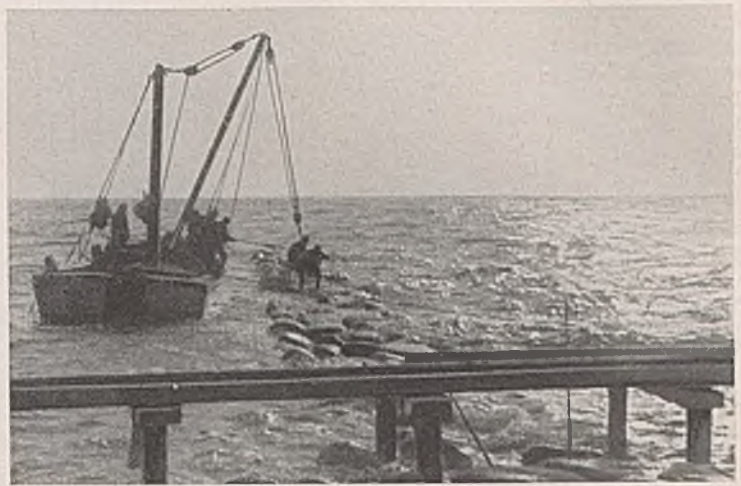
Abb. 9. Bau einer Steinbuhne vor dem Steindamm an der Hücke.
