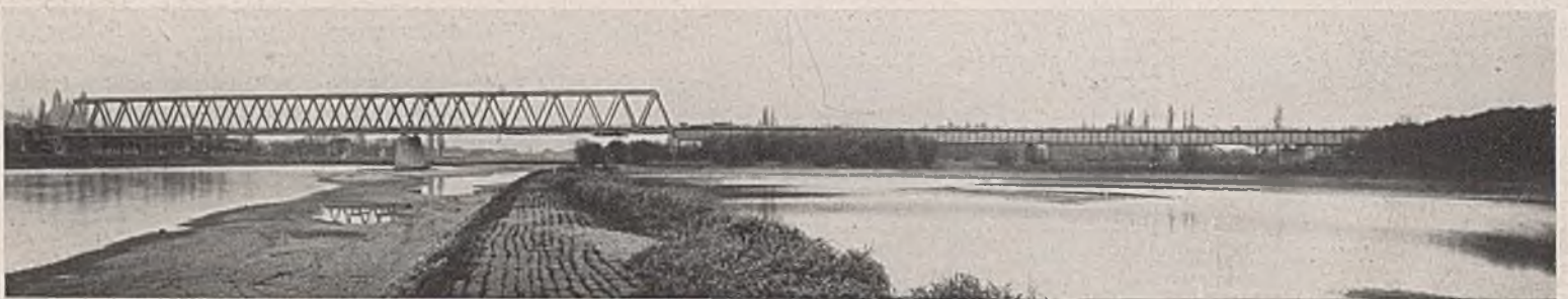
Abb. 13. Rheinbrücke bei Speyer.
