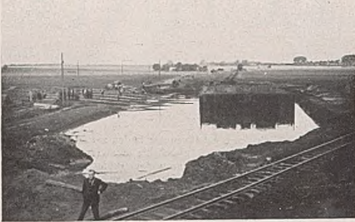
Abb. 3. Stapellauf des Schwimmbaggers.
