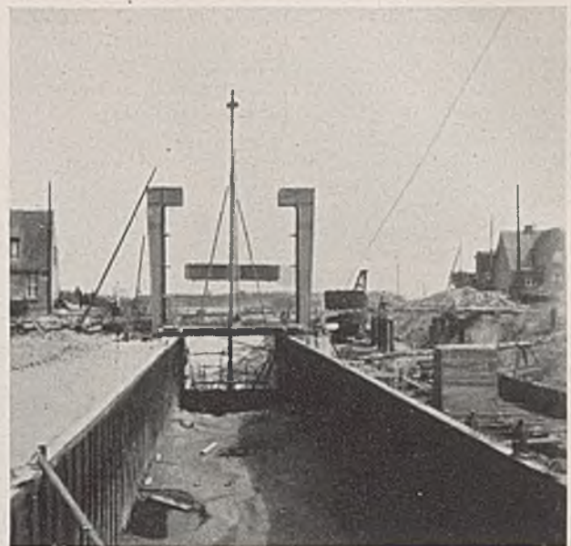
Abb. 14. Schleusenbaustelle. Aufbau eines Hubgerüsts.
