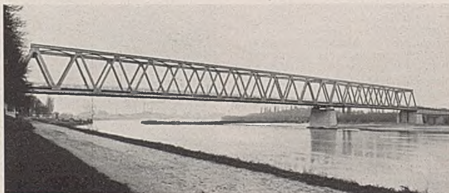
Abb. 14. Stromüberbau der Rheinbrücke bei Speyer.
