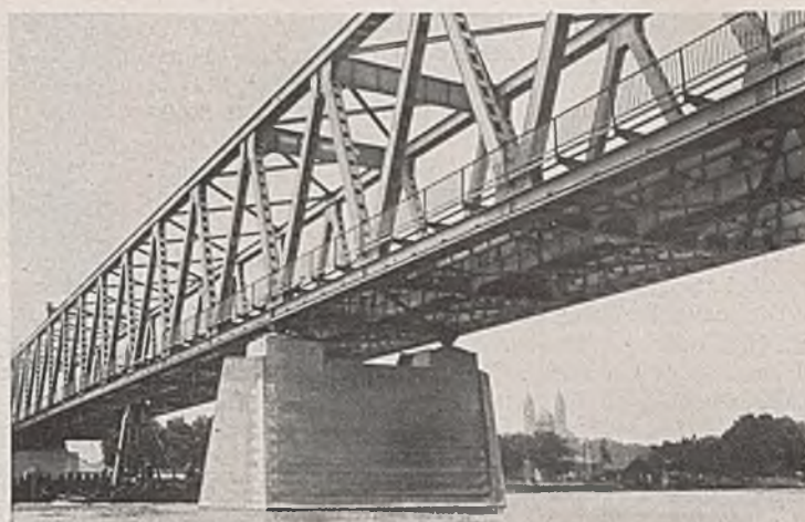
Abb. 15. Einzelheiten des Stromüberbaues der Rheinbrücke bei Speyer.
