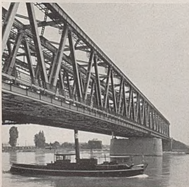
Abb. 17. Rheinbrücke bei Maxau.
