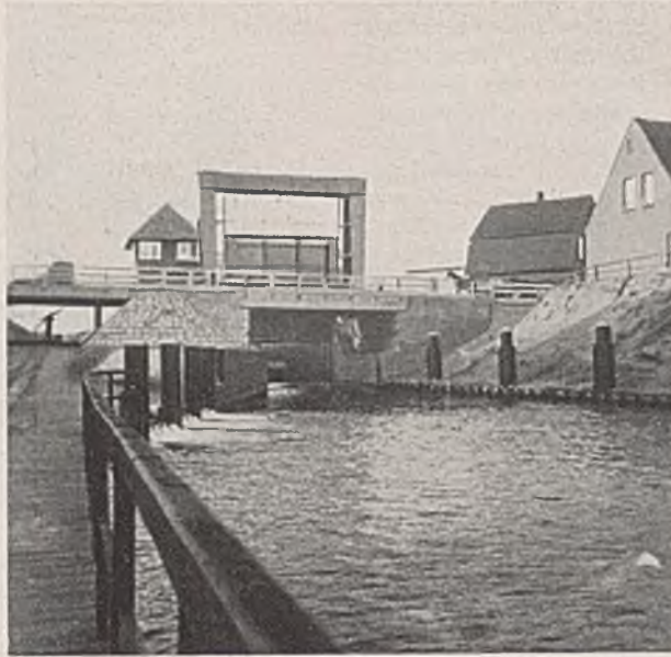
Abb. 16. Schleuse. Ansicht vom Unterhafen.
