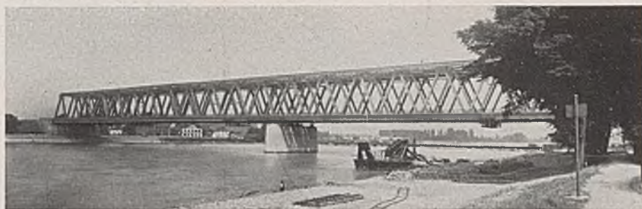
Abb. 16. Rheinbrücke bei Maxau.
