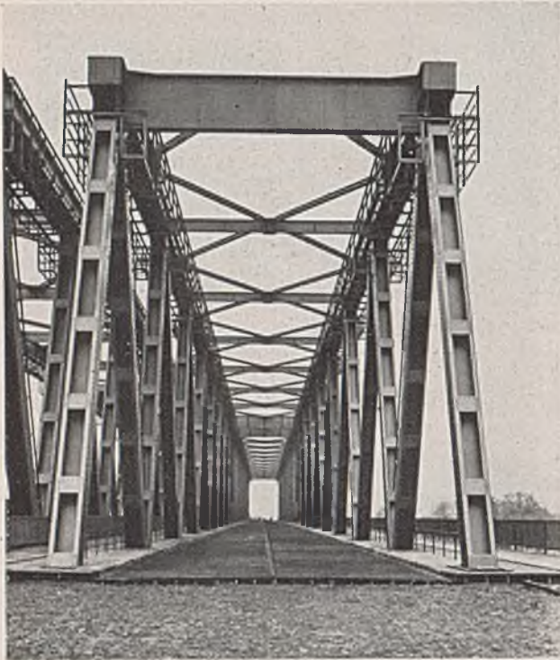
Abb. 18. Blick durch den Straßenüberbau der Rheinbrücke bei Maxau.
