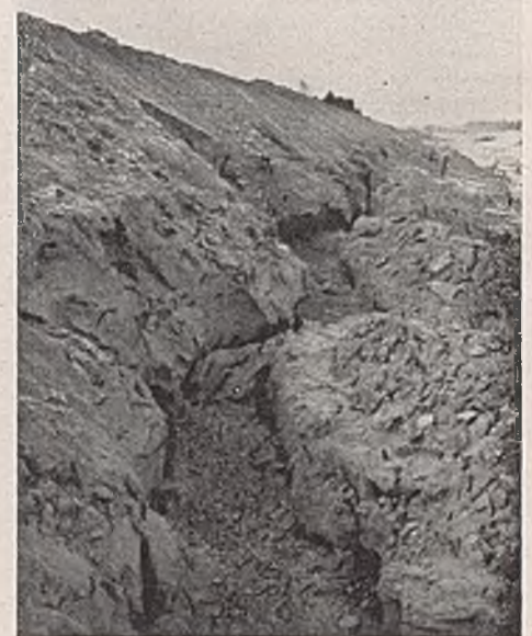
Abb. 5. Böschungsrutschungen.
