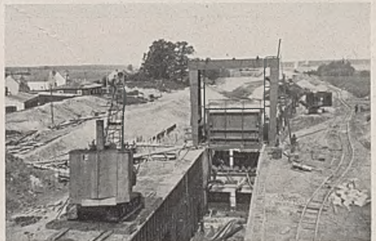
Abb. 15. Schleusenbaustelle. Blick gegen das Oberhaupt.
