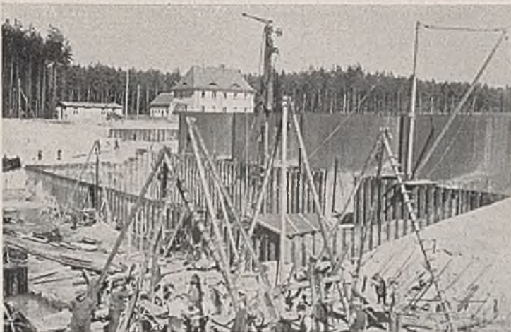
Abb. 25. Schleuse I Klodnitz, Unterhauptbaugrube, rechts die vier Kammerwände aus Peiner Bohlen.
