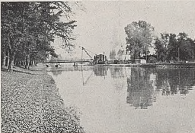
Abb. 23. Bau des Adolf-Hitler-Kanals bei Ehrenforst durch Verbreiterung des Klodnitz-Kanals mittels B-Baggers.
