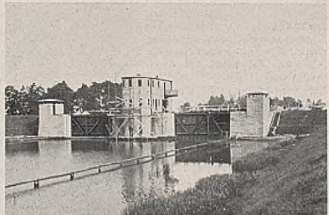
Abb. 26. Schleuse III in Ehrenforst, Ansicht des Unterhauptes.
