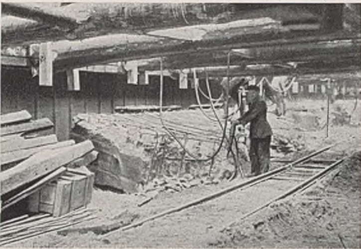
Abb. 27. Schleuse Stauwerder. Abbruch der Eisenbetonsteifen in den Kammersohlen.
