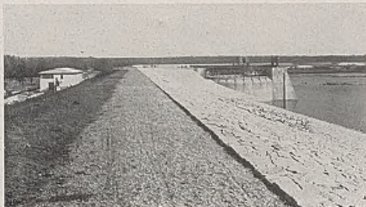
Abb. 34. Staubecken Turawa an der Malapane. Entlastungsanlage und Krafthaus.
