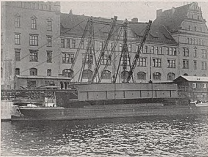
Abb. 9. Entladen der ankommenden Teile.
