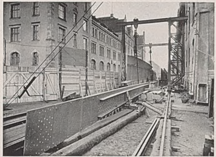
Abb. 10. Zusammenbau der Brückenteile auf der Baustelle.
