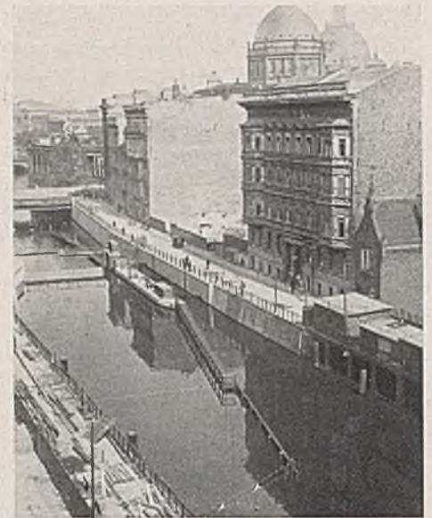
Abb. 42. Wehr- und Sportschleusenanlage im Spreekanal (Berlin).
