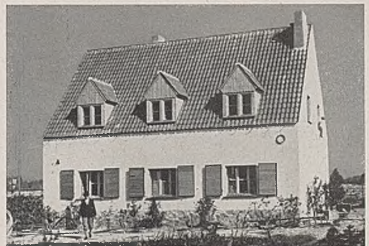
Abb. 40. Umgebaute Fischhälterei am Stausee Ottmachau.
