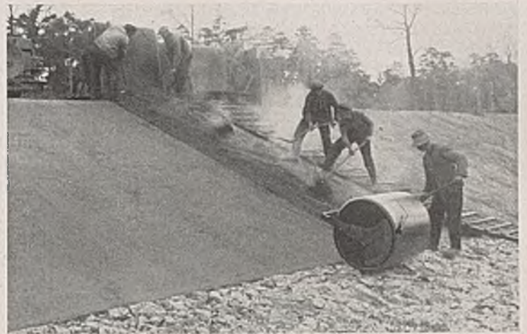
Abb. 36. Staubecken Turawa an der Malapane. Aufbringen des Walzgußasphaltbelags auf den Enden der wasserseitigen Böschungen.
