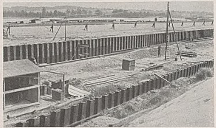
Abb. 33. Hafen Gleiwitz. Südwand des Güterbeckens aus Larssenbohlen nebst Ankerwand.
