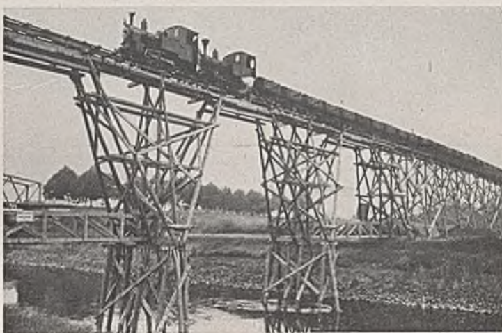
Abb. 2. Förderbrücke zur Schüttung der Rampen.
