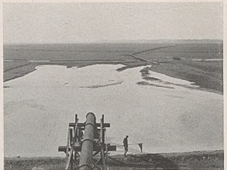
Abb. 7. Spülbecken Kudensee von oben, nach Aufnahme einer Baggerladung.
