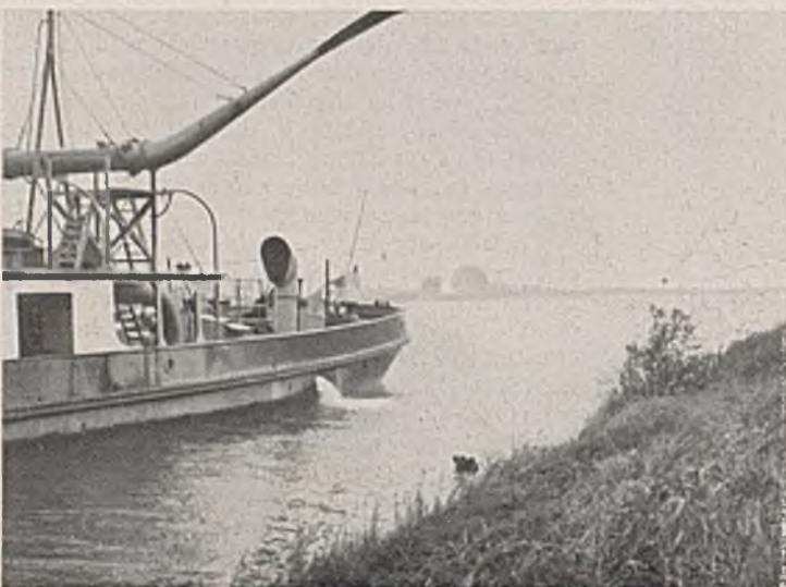
Abb. 13. Bagger in Spritztätigkeit. Anfang des Spritzstrahles.
