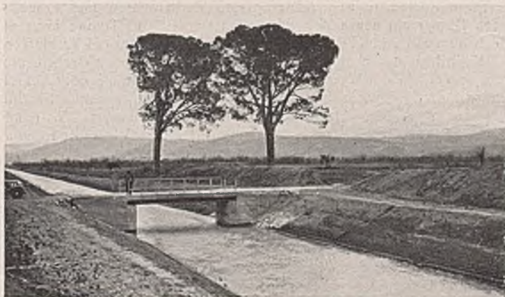
Abb. 3. Hauptkanal zur Entwässerung der Sümpfe.
