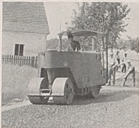
Abb. 3. Dieselmotor-Einradwalze beim bituminösen Straßenbau.
