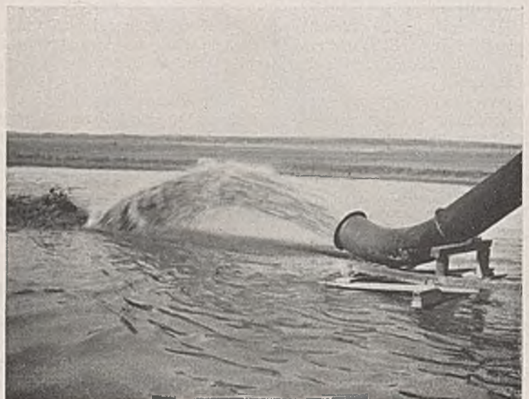
Abb. 5. Spülrohrauslauf am Spülbecken Kudensee.
