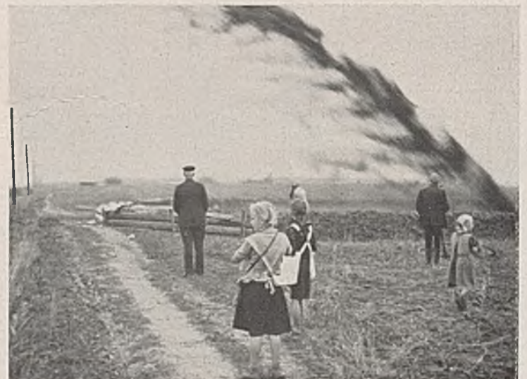
Abb. 13a. Bagger in Spritztätigkeit. Ende des Spritzstrahles.
