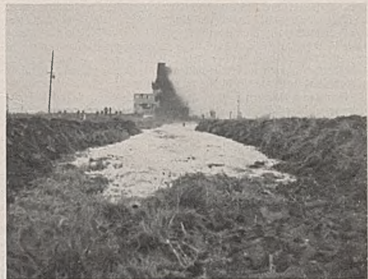
Abb. 16. Bagger in Spritztätigkeit. „Der Schlickstrom kommt.“
