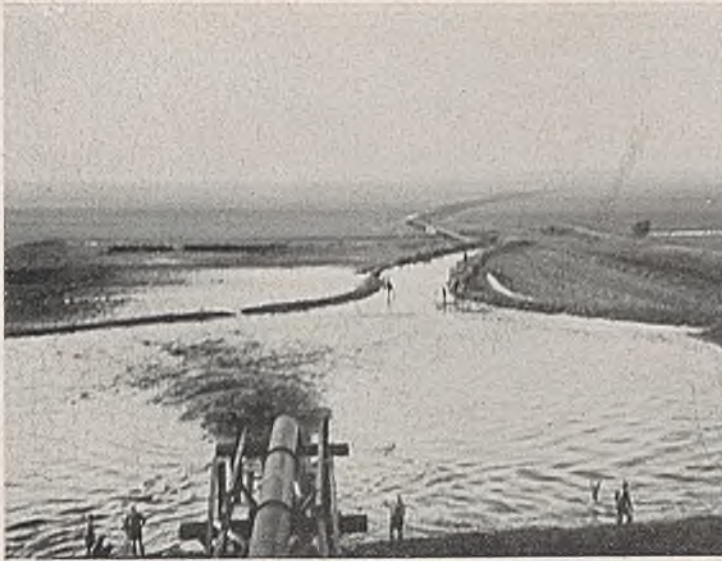
Abb. 6. Spülbecken Kudensee von oben während des Spülens.
