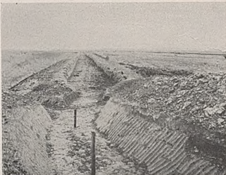
Abb. 15. Schlickrinne mit Abzweigung vor Beginn der Arbeiten.
