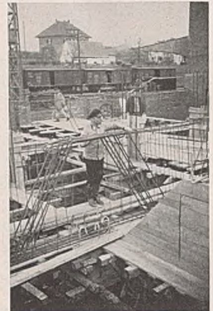
Abb. 7. Bewehrung des Trichterbalkens im zweiten Bauabschnitt.
