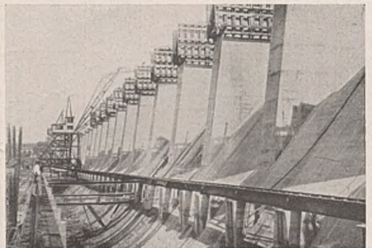
Abb. 6. Fahrbare Drehkrane von 10 t Tragkraft und 23 bis 30 m Ausladung.
