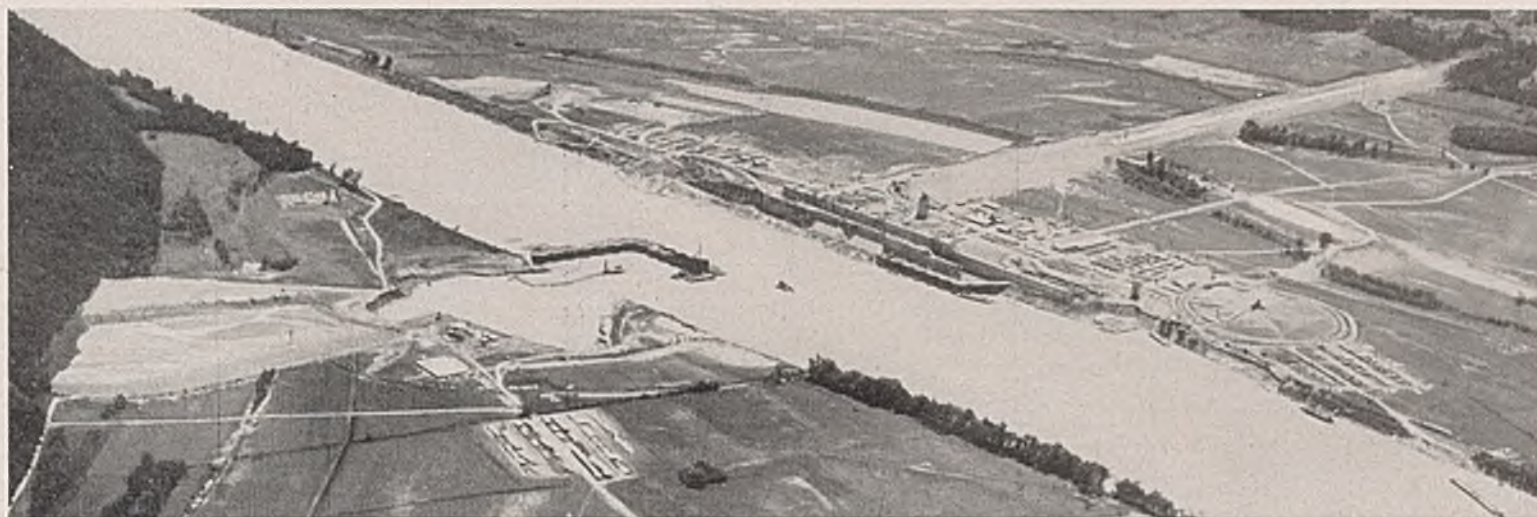
Abb. 16. Pickwick Landing-Baustelle: Beseitigung des Schleusen- und Bau des Krafthaus-Fangedammes (Luftbild).
