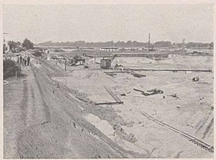
Abb. 50. Doppelschleuse der Staustufe Magdeburg. Baugrube der Unterhäupter nach dem ersten Baggerschnitt.
