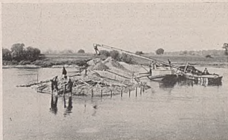
Abb. 48. Herstellung eines Buhnenkopfes an Baustrecke Elster—Gallin.
