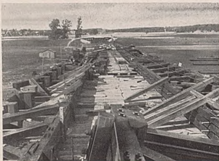
Abb. 6. Zusammenbau der Howeschen Träger auf dem Gerüst.
