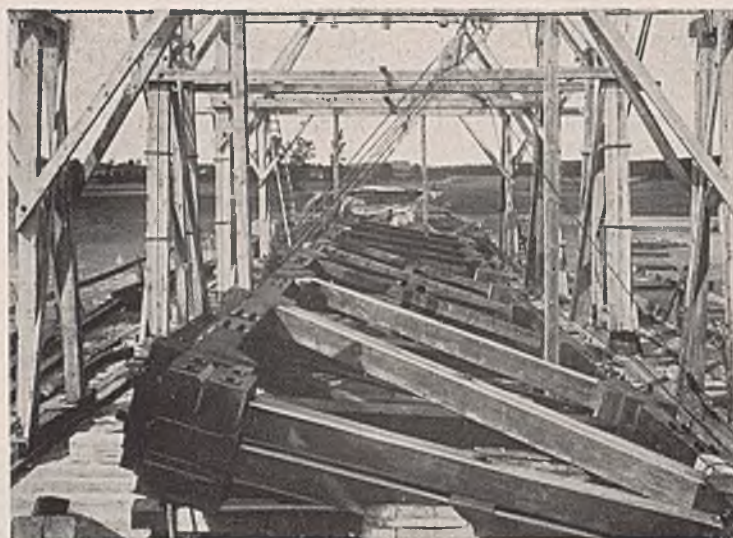
Abb. 7. Aufrichten eines Hauptträgers für die Stromöffnung.
