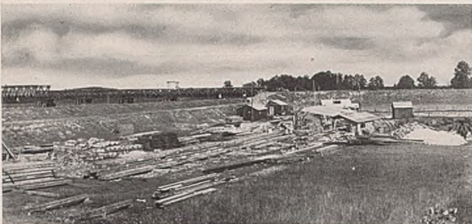
Abb. 5. Ansicht des Werkplatzes und des linken Brückenteiles.
