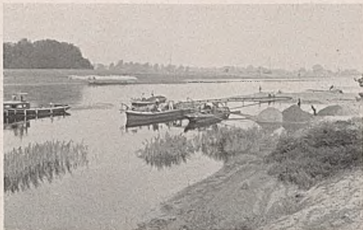
Abb. 45. Bau einer Zwischenbuhne bei Weßnig.
