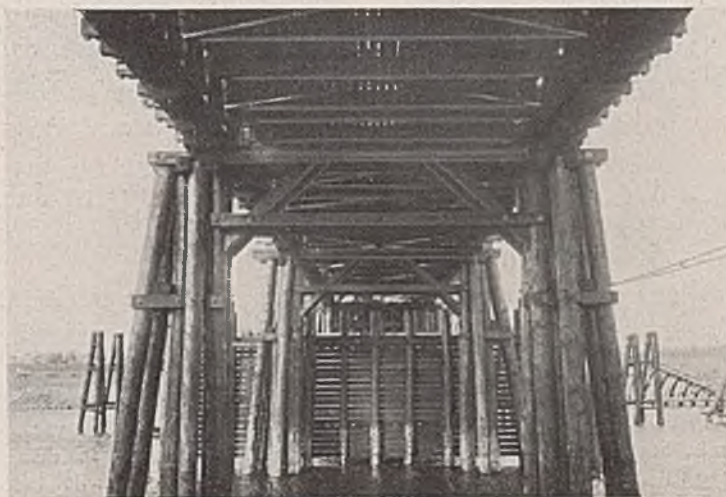
Abb. 3. Untersicht der Brücke mit Pfahlloch und Leitwerk.
