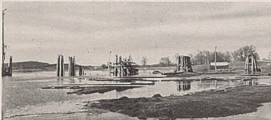
Abb. 4. Rammarbeiten an den Pfahljochen.
