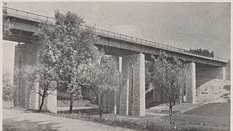
Abb. 15. Reichsautobahnbrücke über das Hirschfeldtal.
