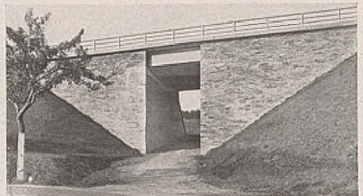
Abb. 6. Wirtschaftswegeunterführung bei Plauen. Hammerrechtes Bruchsteinmauerwerk.
