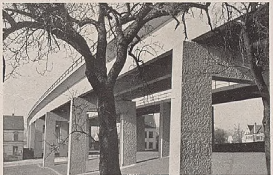
Abb. 3. Brücke bei Frankenhausen.
