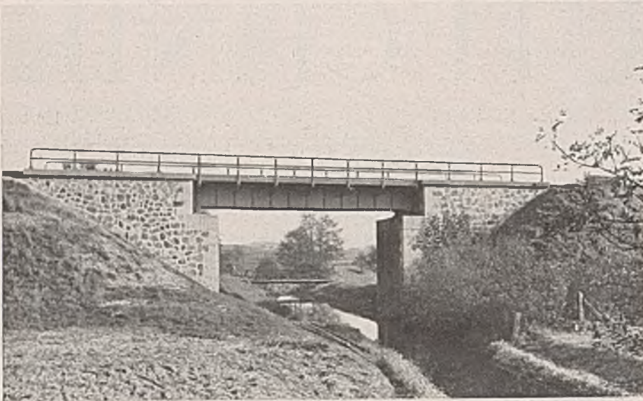
Abb. 4. Eisenbahnbrücke über die Steinau bei Büchen. Findlingsmauerwerk.
