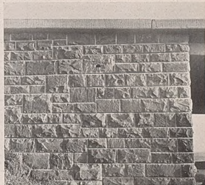
Abb. 20. Flügelmauer eines Widerlagers einer Überführung bei Plauen.
