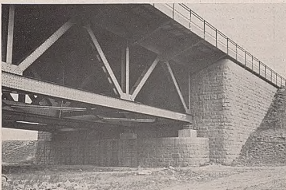
Abb. 18. Widerlager der Elbebrücke bei Dresden.
