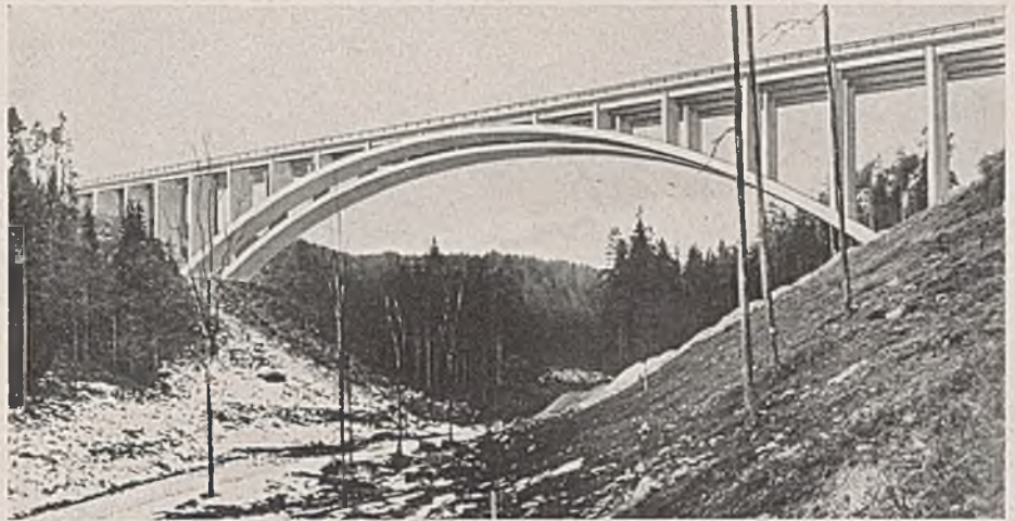
Abb. 1. Brücke über das Teufelstal.
