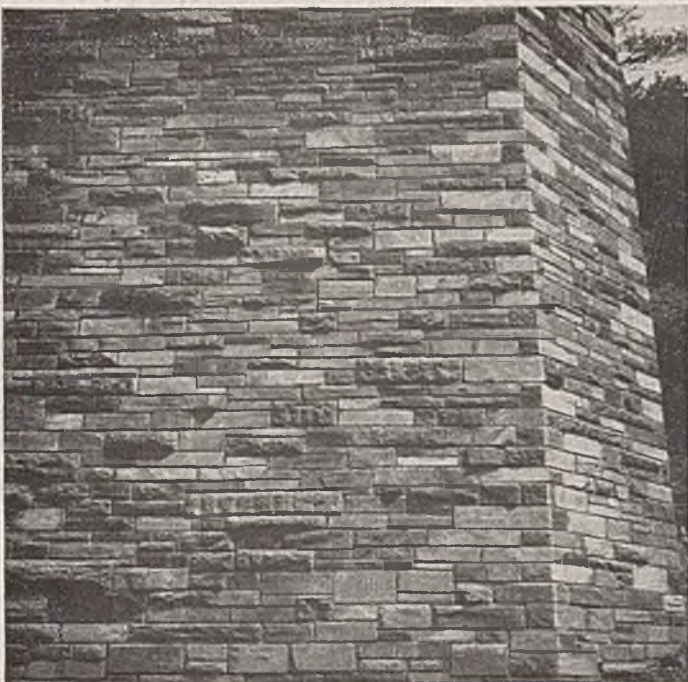
Abb. 9. Einzelheiten des unregelmäßigen Schichtenmauerwerks des Pfeilers nach Abb. 8.
