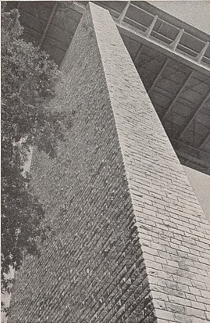
Abb. 22. Regelmäßiges Schichtenmauerwerk eines Pfeilers der Reichsautobahnbrücke über das Muldetal bei Siebenlehn.
