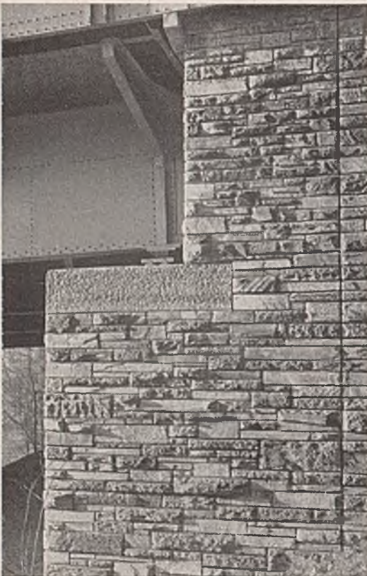
Abb. 13. Lützelbachtalbrücke. Auflagerpunkt. Unregelmäßiges Schichtenmauerwerk.
