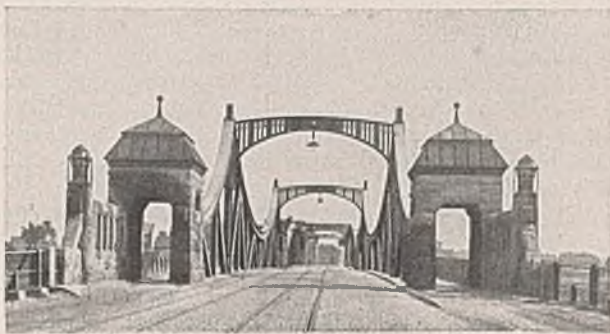
Abb. 4. Portal einer größeren Straßenbrücke. Baujahr 1909.
