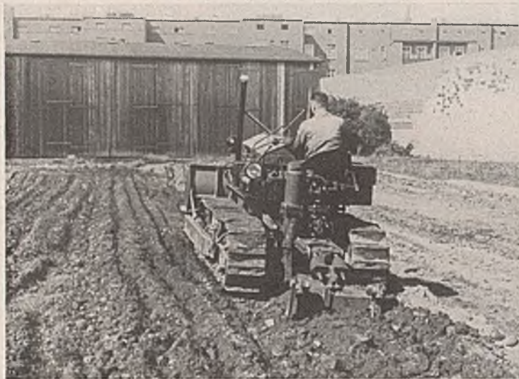
Abb. 2. Tiefreißer beim Arbeiten. (Bauart Menck & Hambrock G.m.b.H.).
