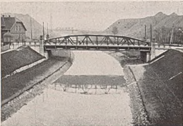
Abb. 1. Straßenbrücke über die Emscher aus Stahl.
