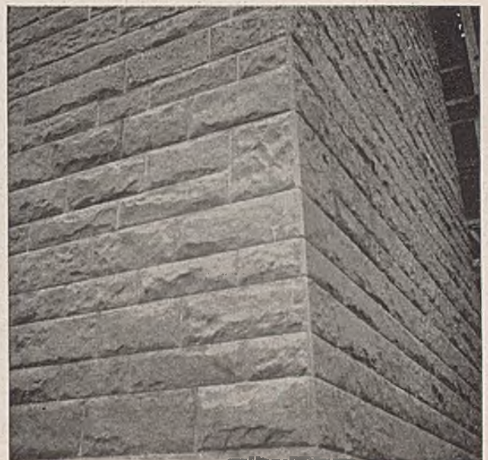
Abb. 41. Einzelheiten des Mauerwerkes der Pfeiler der Waschmühlalbrücke.
