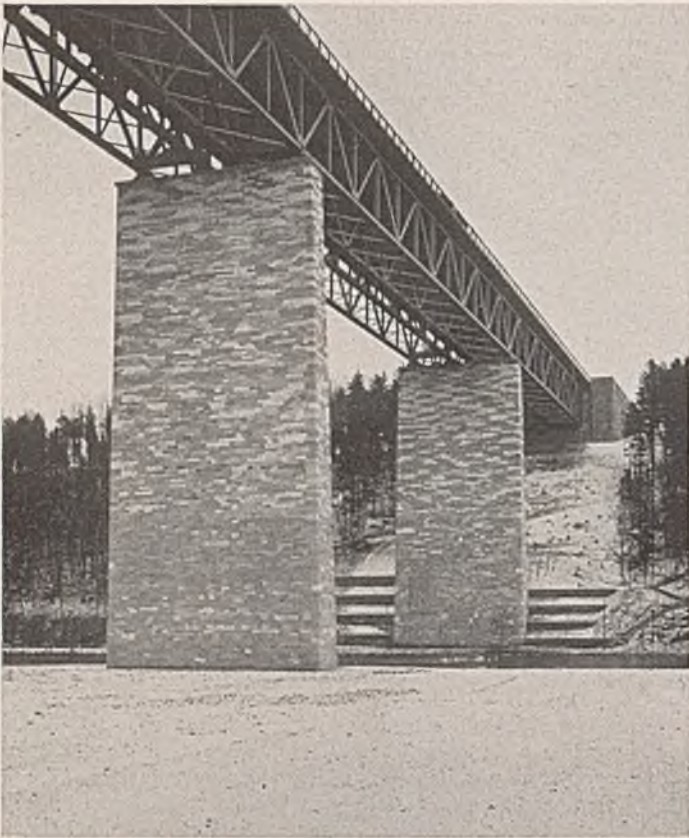
Abb. 25. Werrabrücke bei Hedemünden.
