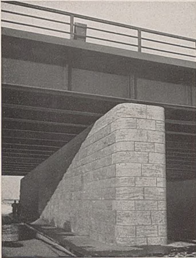
Abb. 30. Pfeiler des Kreuzungsbauwerkes bei Herrndorf.
