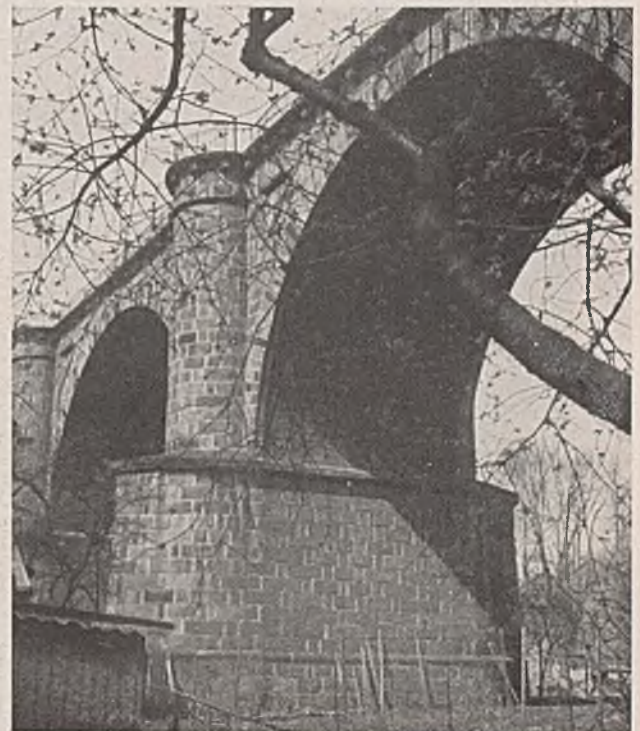
Abb. 32. Eisenbahnviadukt bei Bautzen.
