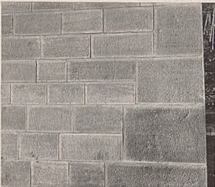
Abb. 27. Einzelheiten des Mauerwerkes der Pfeiler der Werrabrücke.
