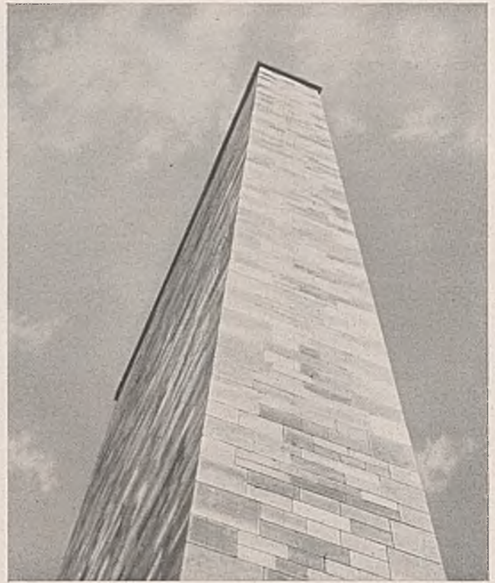
Abb. 26. Pfeiler der Werrabrücke.
