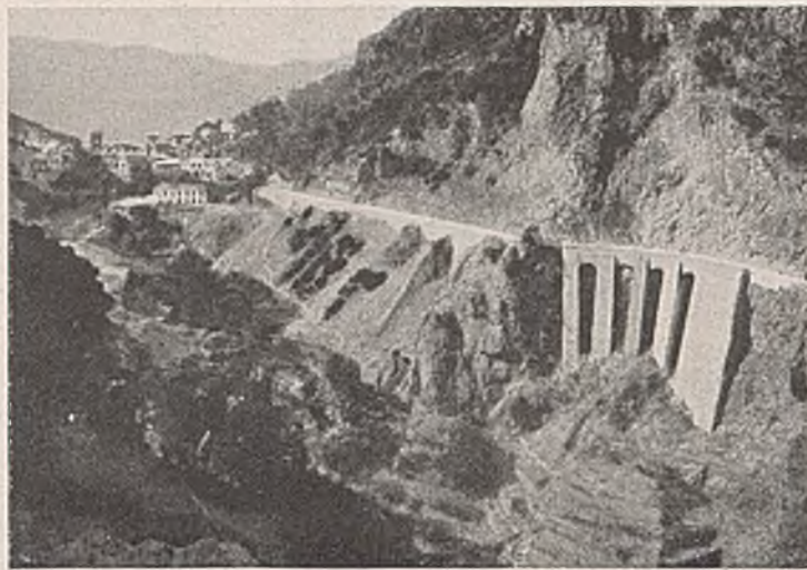
Abb. 3. Viadukt mit Futtermauern der Staatsstraße bei Pazzano (Kalabrien).
