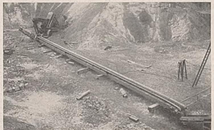
Abb. 4. Förderbandreihe aus vier versetzbaren Förderbändern von je 7,5 m Achsabstand mit Antrieb durch einen Trommelmotor. (Bauart Bleichert.)
