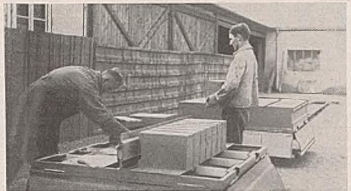
Abb. 5. Herstellung von Porenbeton in fahrbaren Formen.
