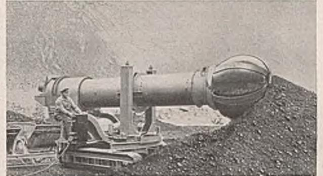
Abb. 3. Kugelschaufler beim Beladen von Muldenkippern. (Bauart Bleichert.)
