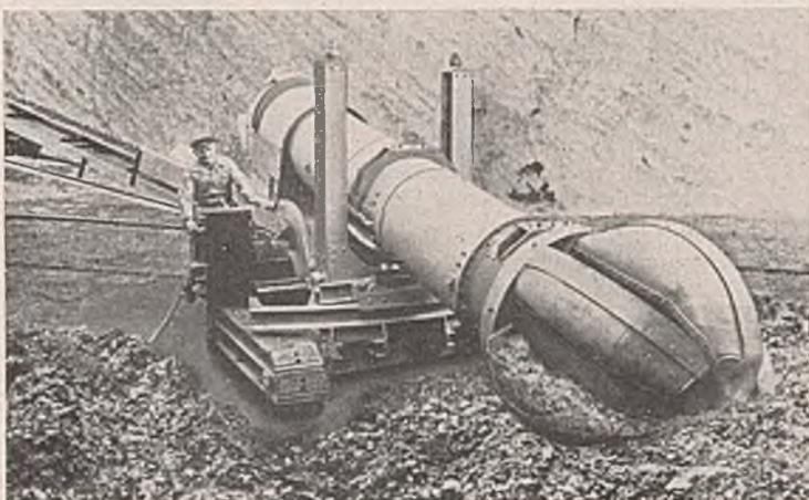
Abb. 2. Ansicht eines Kugelschauflers von vorn. (Bauart Bleichert.)
