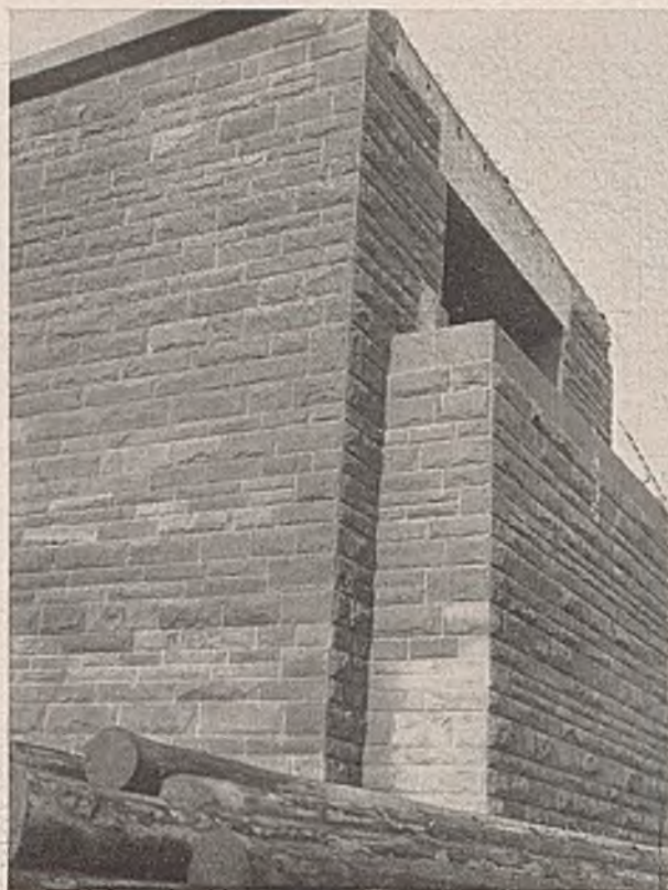
Abb. 10. Ansicht des Widerlagers.
