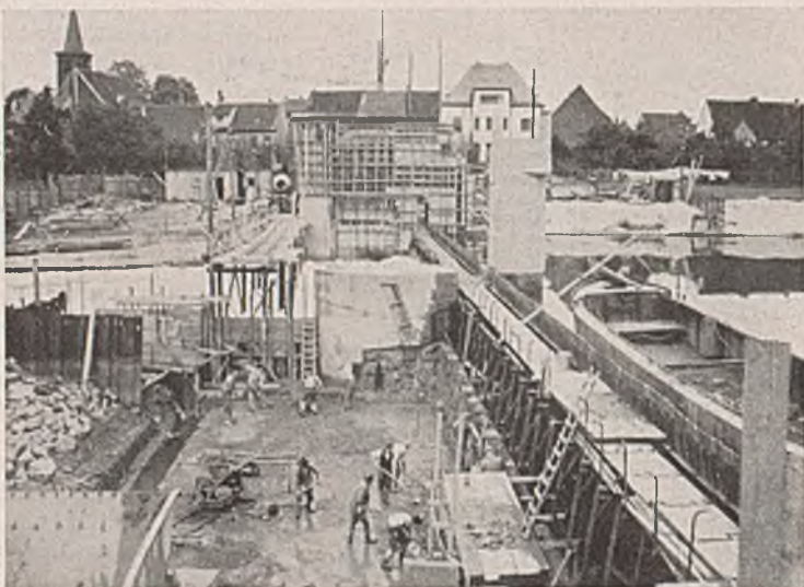
Abb. 93. Umbau der Wehranlage Gündingen.
