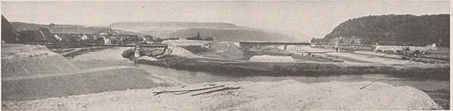
Abb. 92. Saardurchstich III bei Rehlingen mit alter und neuer Straßenbrücke.
