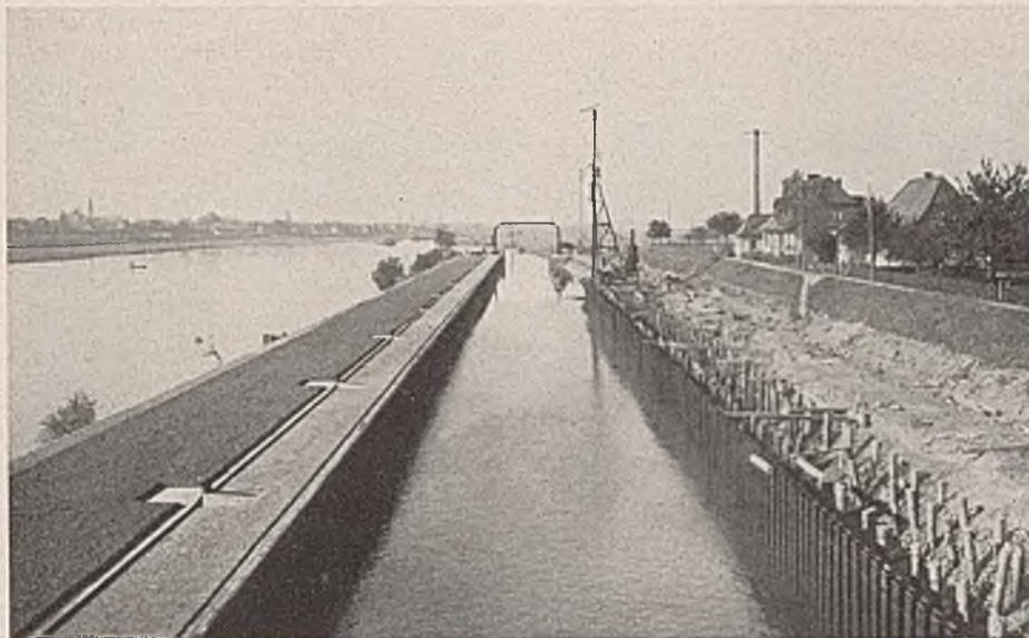
Abb. 91. Umbau der Schleuse Kesselstadt/Main.
