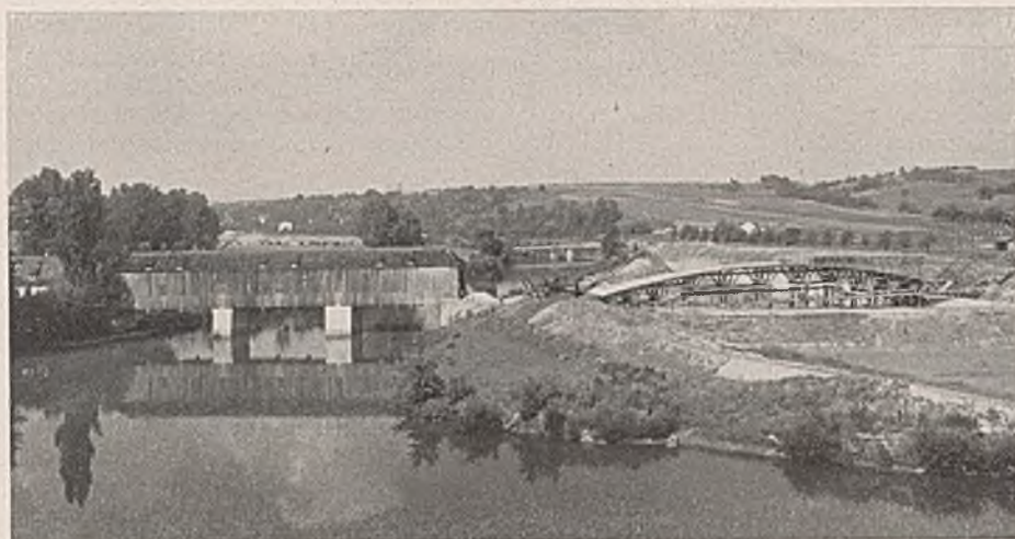
Abb. 101. Alte Holzbrücke und Lehrgerüst der neuen Eisenbetonbrücke bei Neckarrems.
