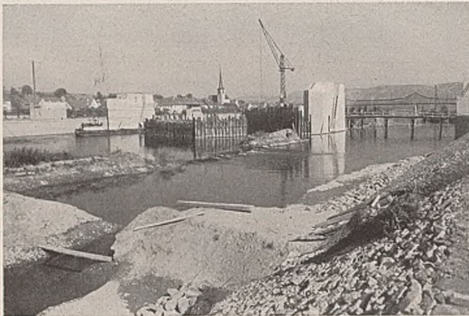
Abb. 98. Staustufe Himmelstadt. Rechte Wehrröfnung unter Wasser, mittlere im Bau.
