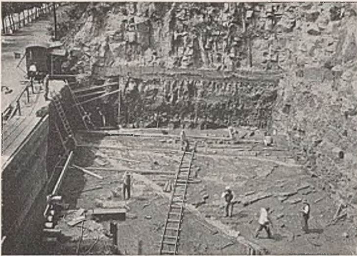
Abb. 9. Baugrube von Pfeiler 1 (rechts 20 m hohe Felswand).
