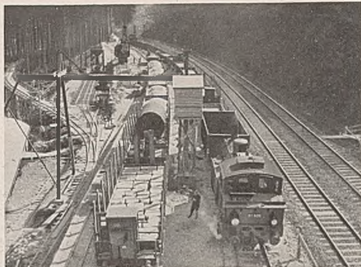
Abb. 36. Anschlußbahnhof auf der Baustelle.
