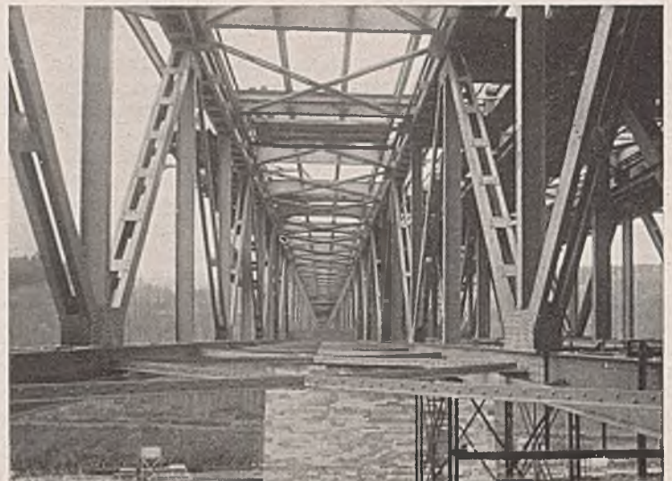
Abb. 28. Anordnung der Windverbände.
