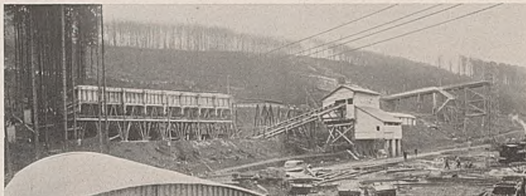
Abb. 37. Lager und Mischanlage für den Beton.
