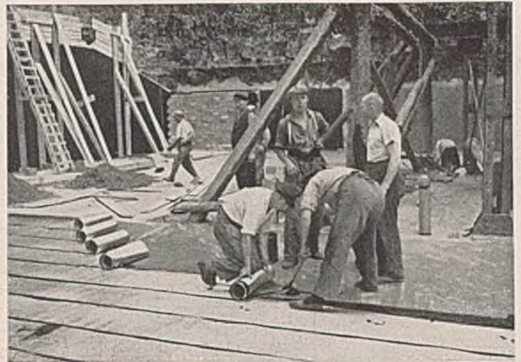
Abb. 10. Verlegen der Dichtung.
