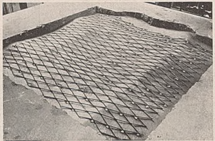
Abb. 25. Eingeschweißtes Streckmetall im Mittelfelde.
