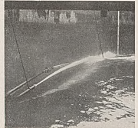
Abb. 5. Strahlrohr in Tätigkeit (über Wasserspiegel gehoben).
