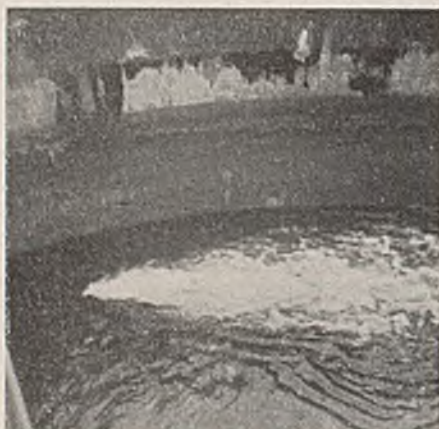
Abb. 6. Beginn der Rückspülung.
