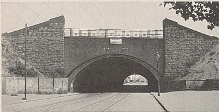
Abb. 4. Gewölbte Unterführung mit Parallelfügeln.
