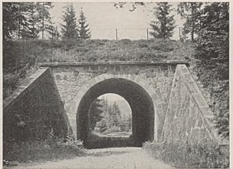
Abb. 2. Gewölbter Durchlaß mit geraden geneigten Schrägflügeln.
