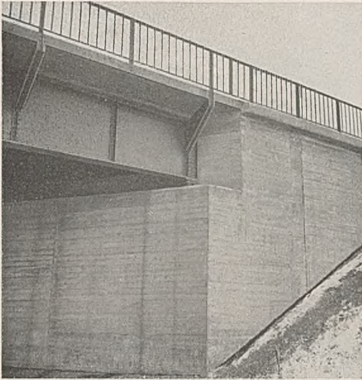
Abb. 18. Schiefe Brücke mit stählernem Überbau und mit Widerlagern mit Parallelfügeln.
