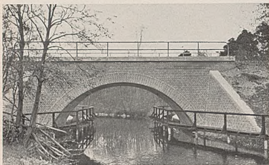
Abb. 5. Gewölbte Unterführung mit geraden, geneigten Schrägflügeln.
