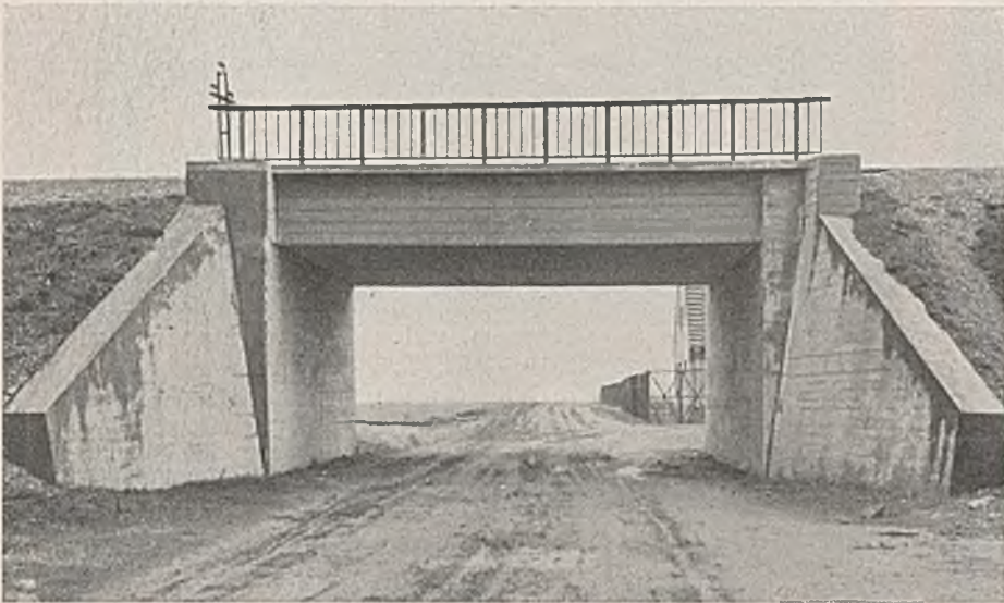
Abb. 10. Eisenbetonbalkenbrücke mit geraden, geneigten Schräglügeln.
