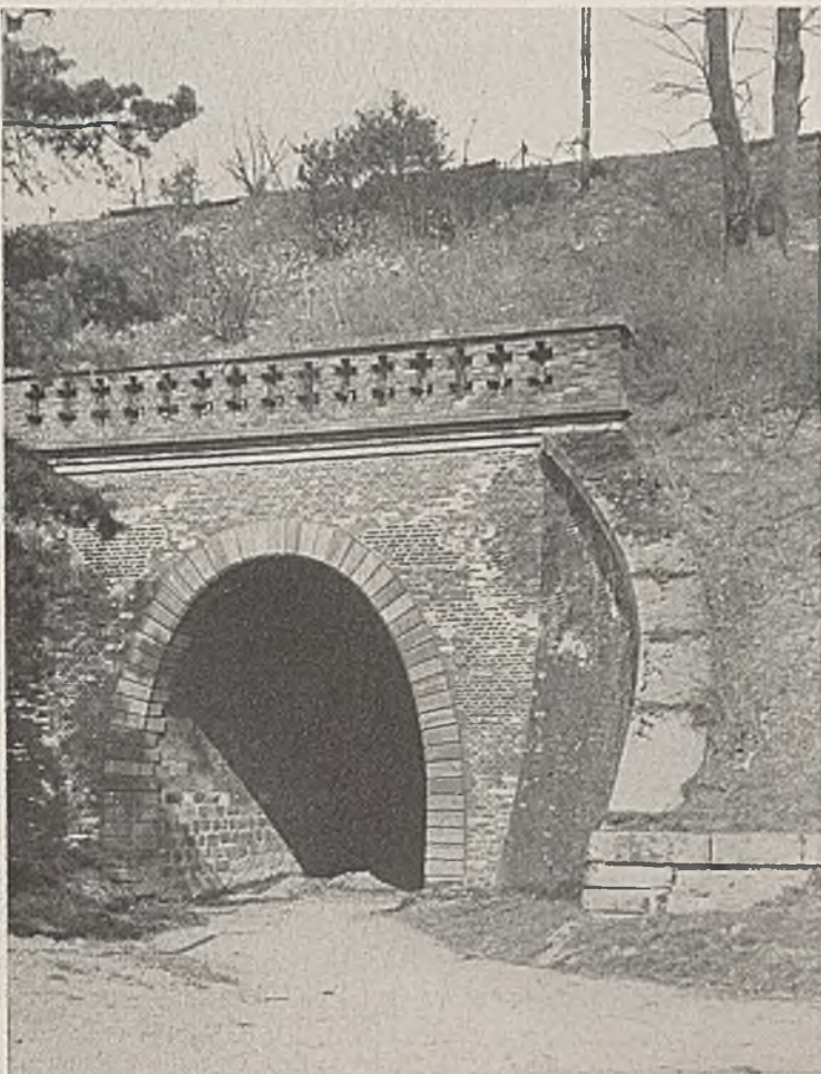
Abb. 3. Gewölbter Durchlaß mit gewölbten geneigten Schrägflügeln.
