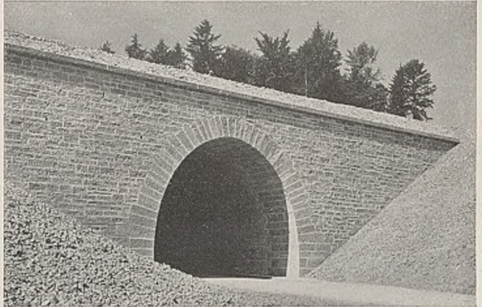
Abb. 1. Gewölbter Durchlaß mit Parallelfügeln.
