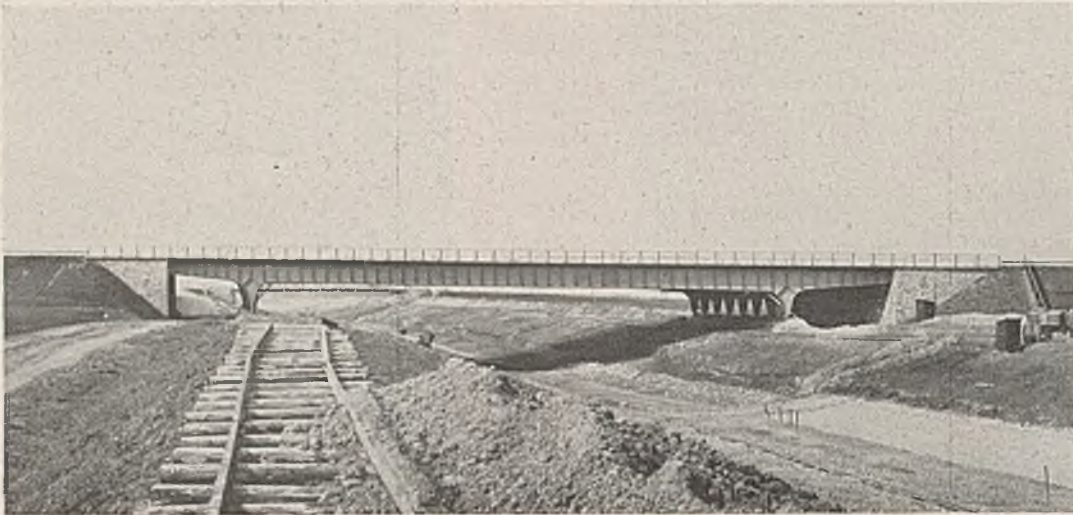
Abb. 1. Ansicht von Osten.
