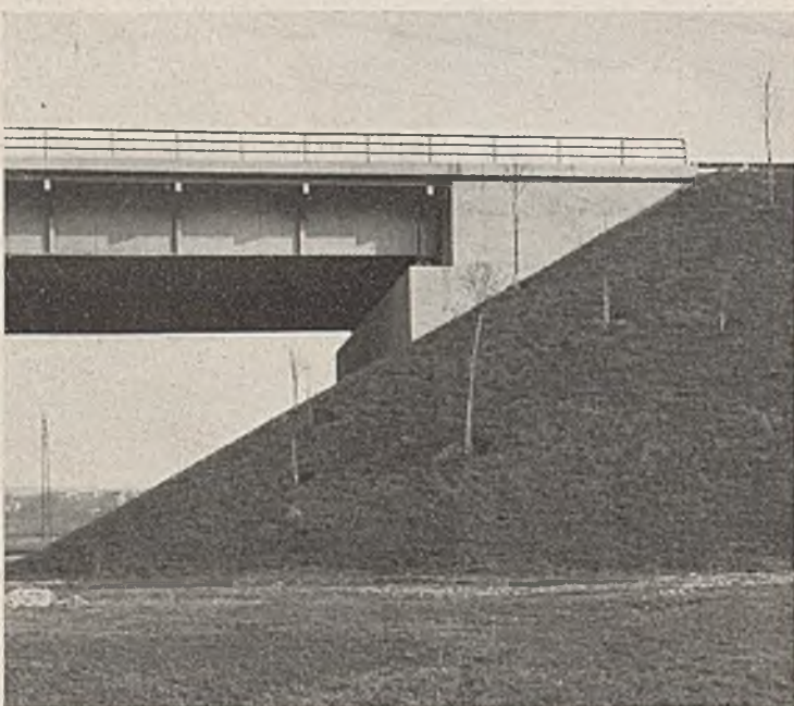
Abb. 36. Brücke mit stählernem Überbau, der offen auf einer hervorspringenden Auflagermauer liegt. Die Parallelfügel liegen mit den Seitenflächen der Auflagermauer bündig.
