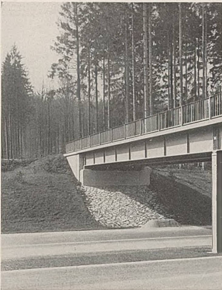
Abb. 38. Ähnlich ausgebildetes Brückenende wie bei der Brücke in Abb. 37.
