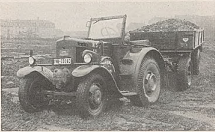
Abb. 8. Einzylinder-Zugmaschine mit Riesenluftreifen beim Fahren auf aufgeweichtem Boden. Lanz.
