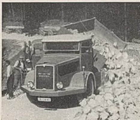
Abb. 1. Diesel-Schwerlastwagen beim Bau der Straße auf den Obersalzberg. Werkphoto MAN.
