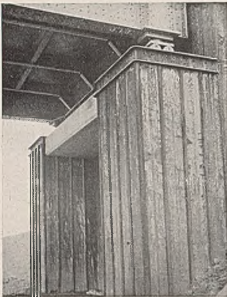
Abb. 11. Ansicht eines fertigen Widerlagers.
