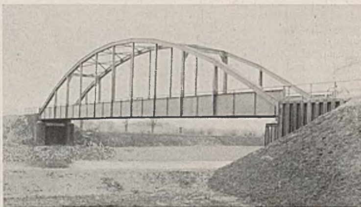
Abb. 12. Ansicht der fertigen Brücke.
