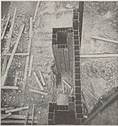
Abb. 8. Aufsicht auf die fertig gerammten Bohlen.
