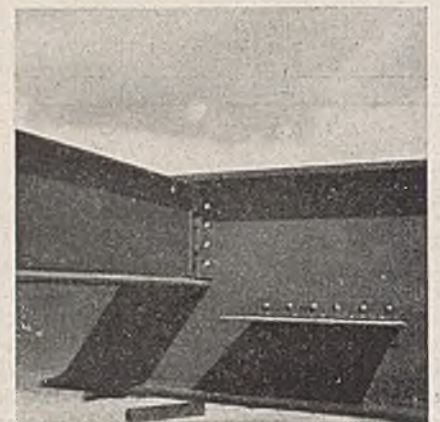
Abb. 6. Anschluß Fahrbahn-längsträger—Querträger.
