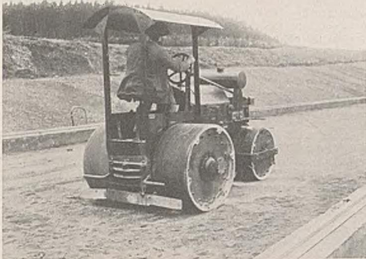
Abb. 2. Dreiradwalze mit veränderlichem Druck durch Wasser- oder Sandfüllungen in den Rädern.
