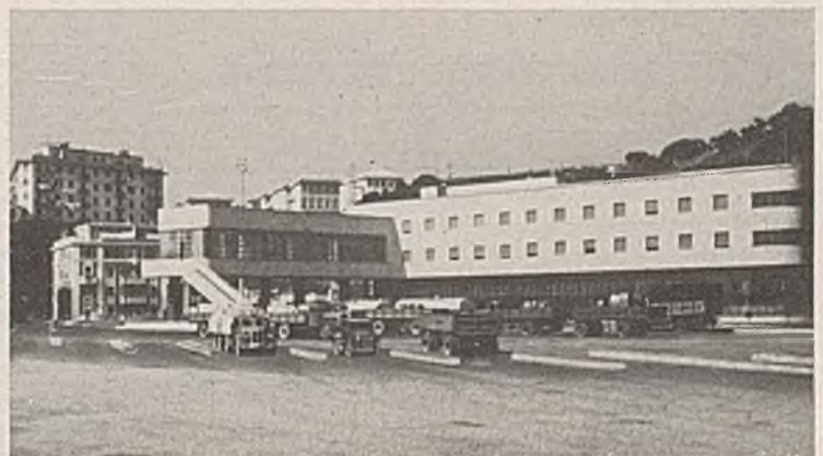
Abb. 7. Verwaltungs- und Übernachtungsgebäude des Autobahnhofes in Genua.
