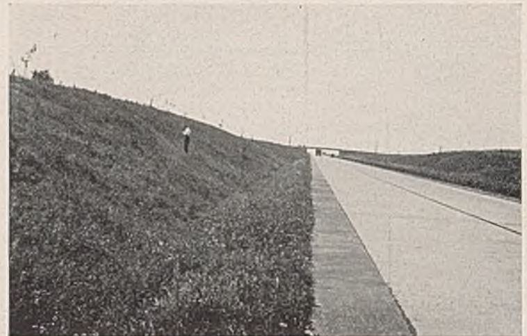
Abb. 1a. Ansicht der gesicherten Böschung nach zwei Jahren.
