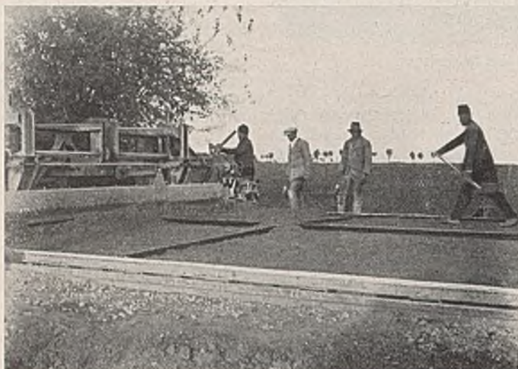
Abb. 3. Dingler-Straßenfertiger, davor eingebaute Wieland-Fugeneisen.
