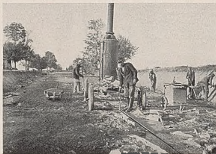
Abb. 5. Erwärmen und Ziehen der Fugeneisen.
