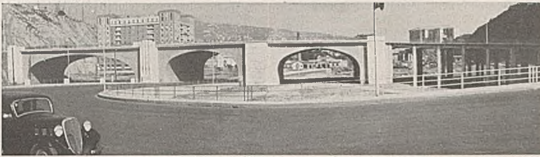
Abb. 5. Schleife der Auffahrtstraße vom Hafen von Genua zum Autobahnhof.
