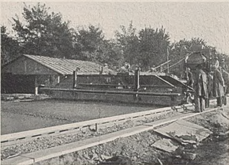
Abb. 8. Eiserne Seitenschalung mit Fahrschiene.
