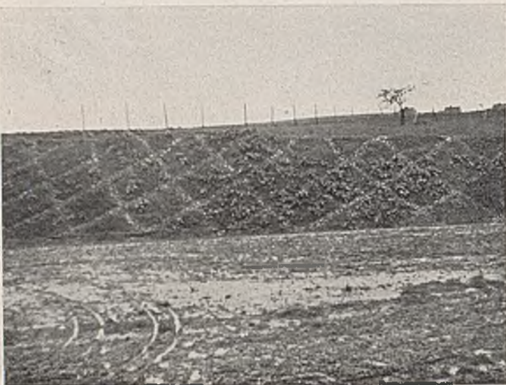
Abb. 11. Sinnlose Anlage von Böschungsrigolen.
