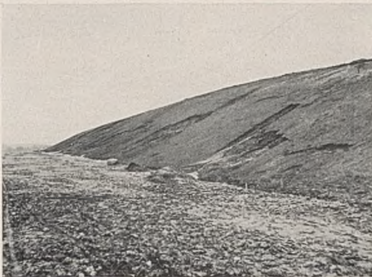
Abb. 4. Rutschung der Hangböschung nach Aufbringen des Mutterbodens.
