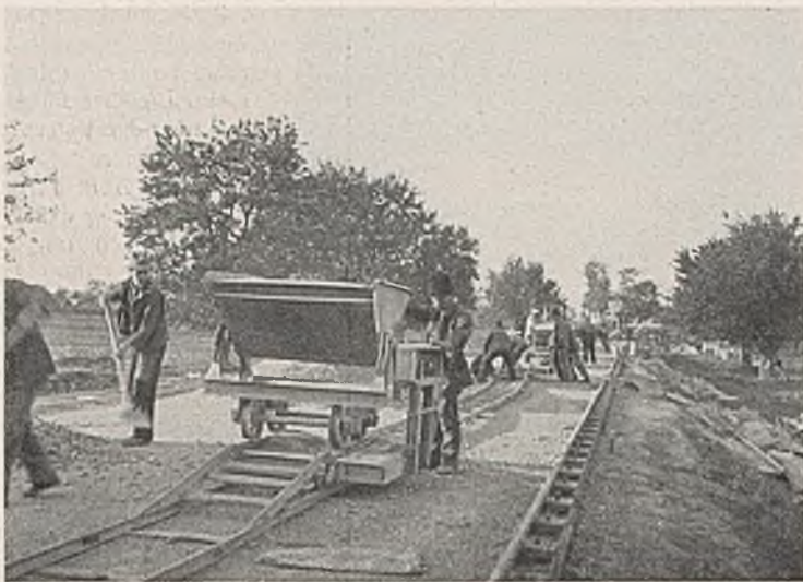
Abb. 6. Abwiegen der Betonzuschlagstoffe.
