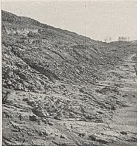
Abb. 2. Erste Rutschung der Hangböschung.
