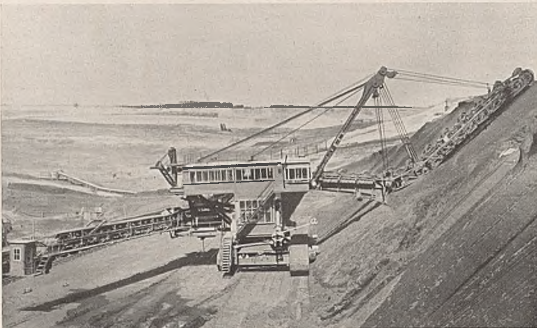
Abb. 2. Ansicht des Baggers.
