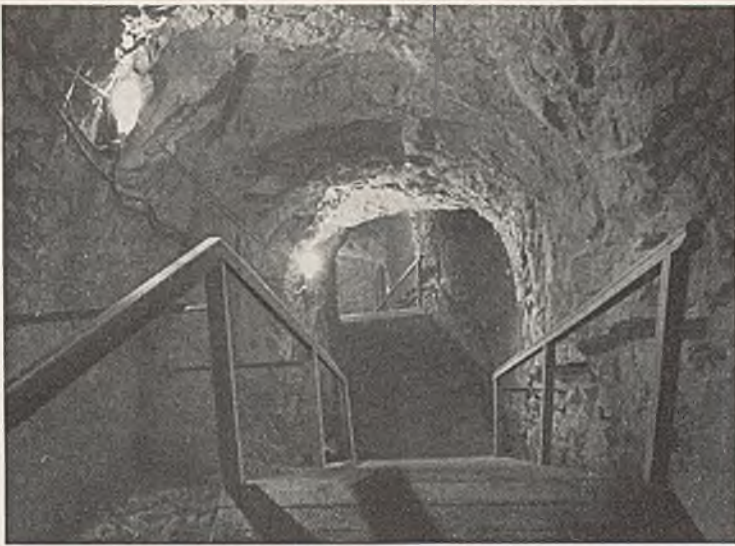
Abb. 5. Bayerischer Zugspitzstollen. Treppenanlagen. Aufnahme: Blumenthal.
