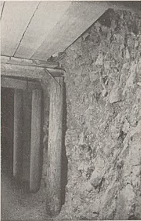
Abb. 10. Bayerischer Zugspitzstollen. Einbau Fenster 5 in Zertrümmerungszone. Werkaufnahme.
