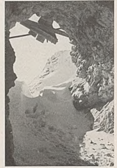
Abb. 11. Bayerischer Zugspitzstollen. Fenster 5, Ausbauzustand Februar 1938. Werkaufnahme.
