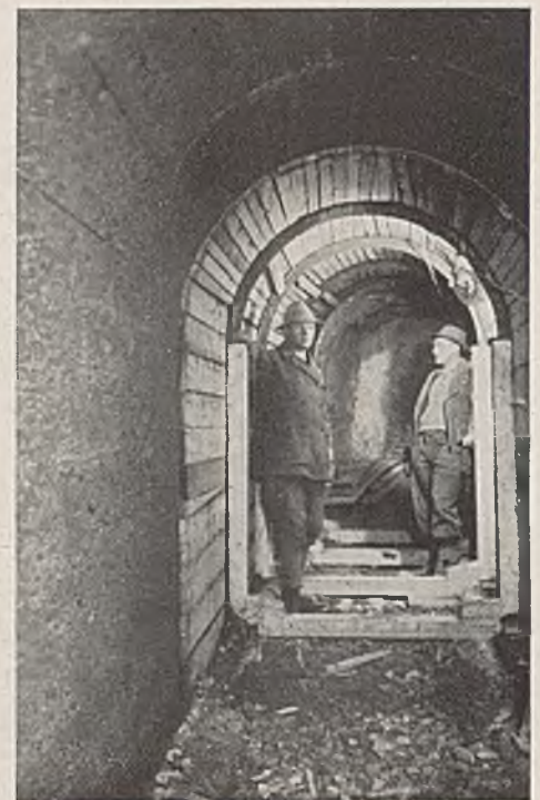
Abb. 4. Bayerischer Zugspitzstollen. Betonierung des Stollens am Fenster 2. Verkaufnahme.
