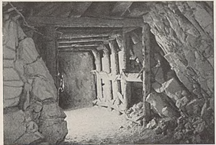
Abb. 9. Bayerischer Zugspitzstollen. Einbau Druckstrecke, Fenster 5. Werkaufnahme.
