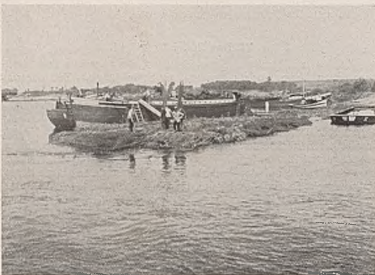
Abb. 2. Einbringen von Busch (Packwerk) in eine Buhne.
