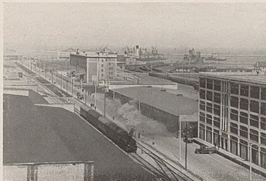
Abb. 14. Polnischer Kai, Ladestraße zwischen Kailschuppen und Speichern. Rechts fünfgeschossiger Eisenbetonspeicher Lager 5, Mitte hinten Tabakspeicher des staatlichen Tabakmonopols.
