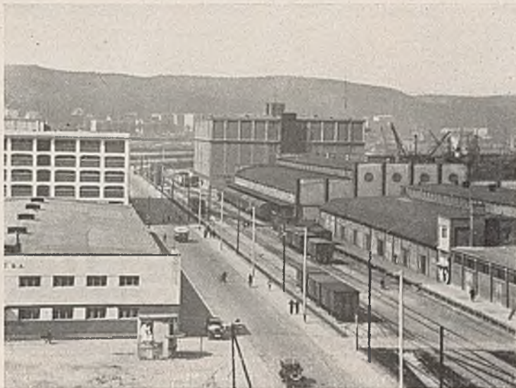
Abb. 12. Polnischer Kai, Ladestraße zwischen Kailschuppen (rechts) mit Hafenkühlhaus (Mitte) und Speichern (links).
