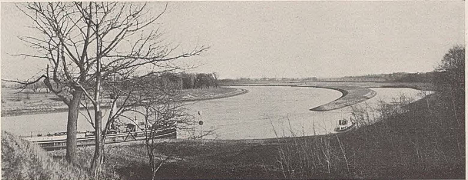
Abb. 4. Abflachung der scharfen Krümmung oberhalb Belgern.
