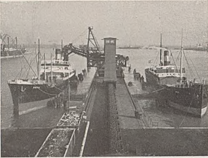
Abb. 6. Kohlenhafen, Pier mit Förderbandanlage.
