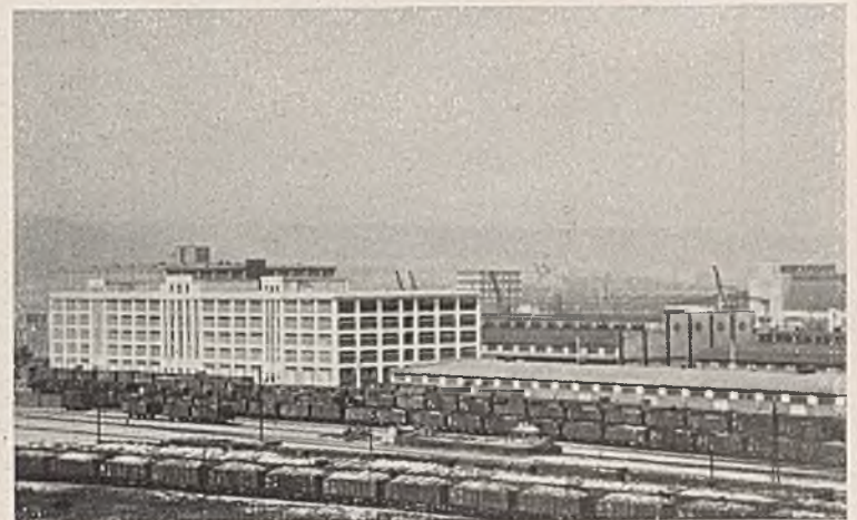
Abb. 13. Eisenbetonspeicher Lager 5 hinter den Kailschuppen des Polnischen Kais, dahinter das Hafenkühlhaus.
