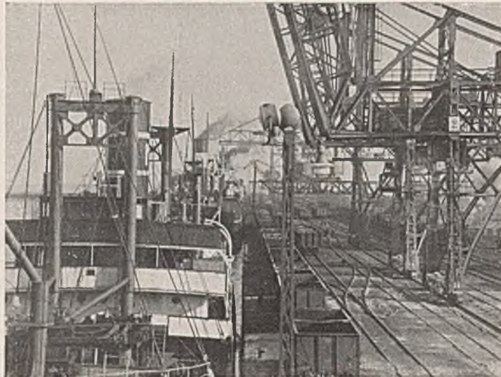
Abb. 8. Verladebrücken für Kohle und Erz am Schwedischen Kai im Kohlenhafen.
