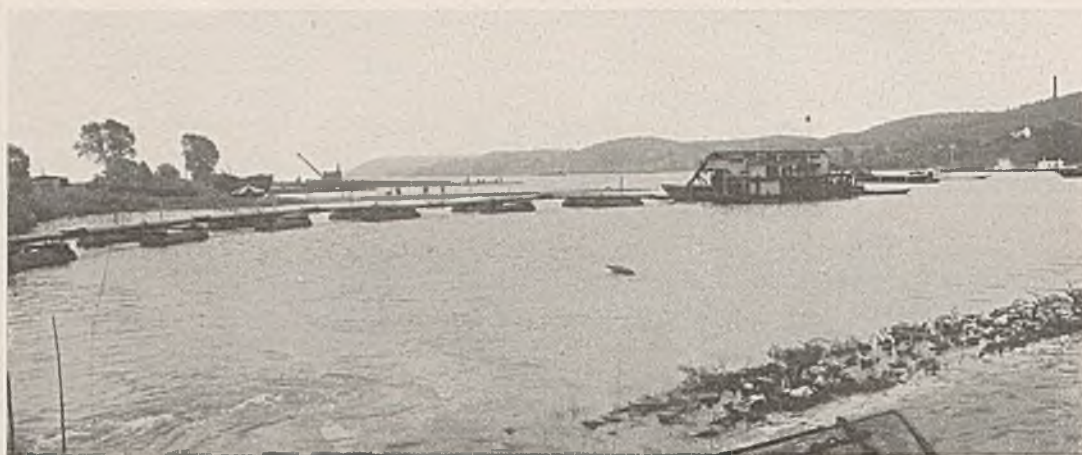
Abb. 6. Spülgerät beim Einbau von Sand in eine Buhne.
