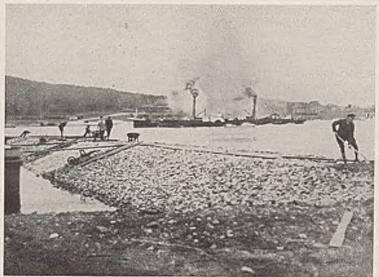
Abb. 3. Abdecken einer Buhne mit Schüttsteinen.
