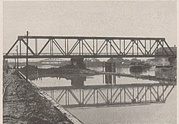
Abb. 10. Neuer Überbau nach dem Abbruch des alten Überbaues.
