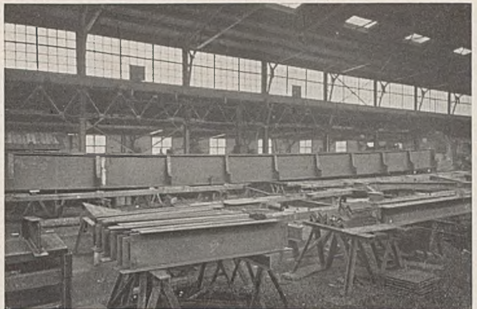
Abb. 11. Hauptträger fertig geschweißt. Querträger fertig geschweißt.
