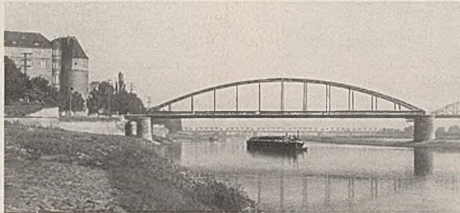
Abb. 19. Elbebrücke bei Torgau.
