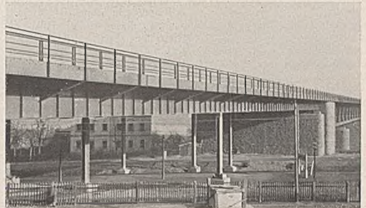
Abb. 26. Reichsautobahnbrücke über die Elbe bei Dresden. Anschlußbrücke.
