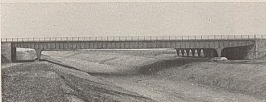
Abb. 29. Reichsautobahnbrücke über den Elster-Saale-Kanal.
