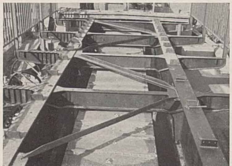
Abb. 26. Windverbandswinkel im Tragwerk.
