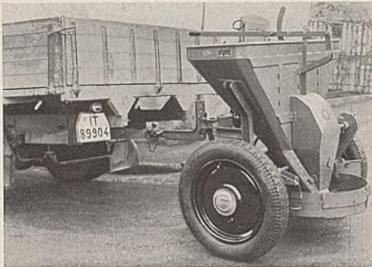
Abb. 5. Splittstreuer mit Schleuderteller für Straßenbreiten bis 10 m.
