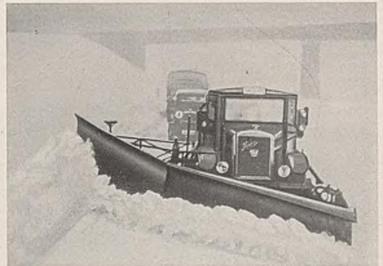
Abb. 3. Schneeräumer für Autobahnen. Für den Betrieb ist ein besonderer Schlepper oder ein Lastwagen mit Allradantrieb nötig.
