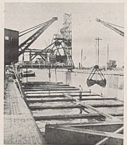
Abb. 9. Bodenaushub bei Oberwasser.
