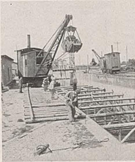
Abb. 7. Einbau der Aussteifungen.
