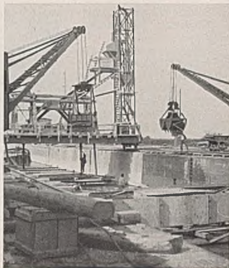
Abb. 10. Zusammenbau der eisernen Schalungsrahmen.
