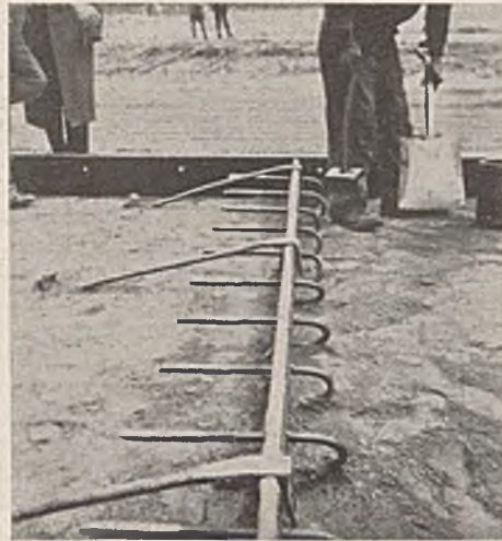
Abb. 1. Vorgeformte Fugeneinlage mit Dübel. Die drei Stützstaken werden nach dem Betonieren entfernt.
