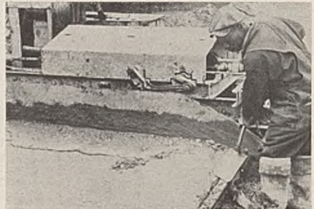
Abb. 5. Abgleichfertiger. Zweiter Arbeitsgang.
