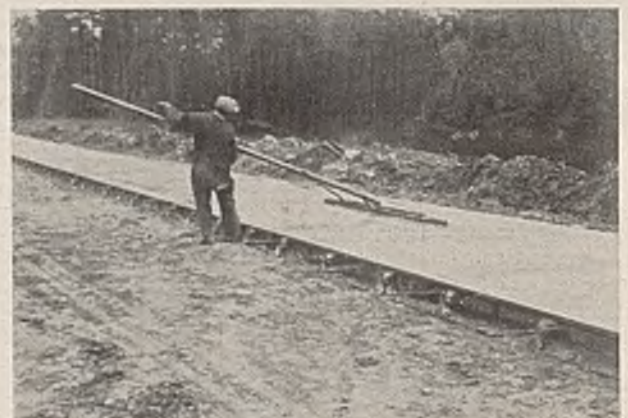
Abb. 6. Abziehen der Oberfläche mit einem Richtscheit.
