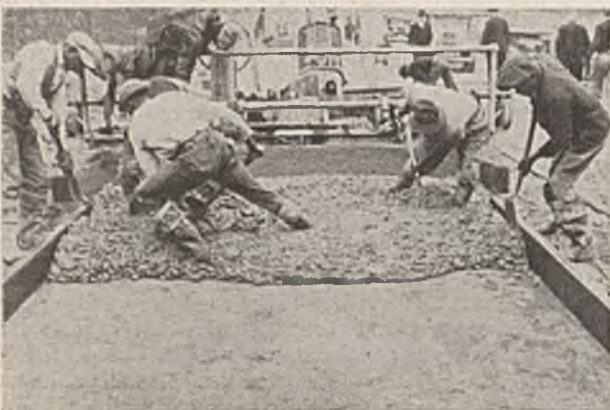
Abb. 4. Verteilen des Betons. Im Hintergrunde der Abgleichfertiger.
