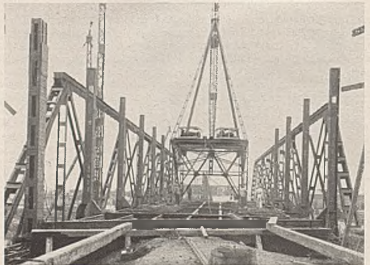
Abb. 26. Alsinabrücke. Einbau einer Brückenhälfte der festen Überbauten innerhalb einer der Montagehilfsbrücken.
