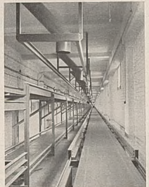
Abb. 15. Innenansicht der Bandbrücke.
