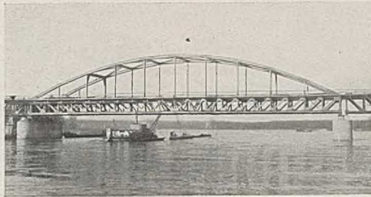
Abb. 14. Neuer Überbau im Zuge der Oderbrücke bei Schwetig.
