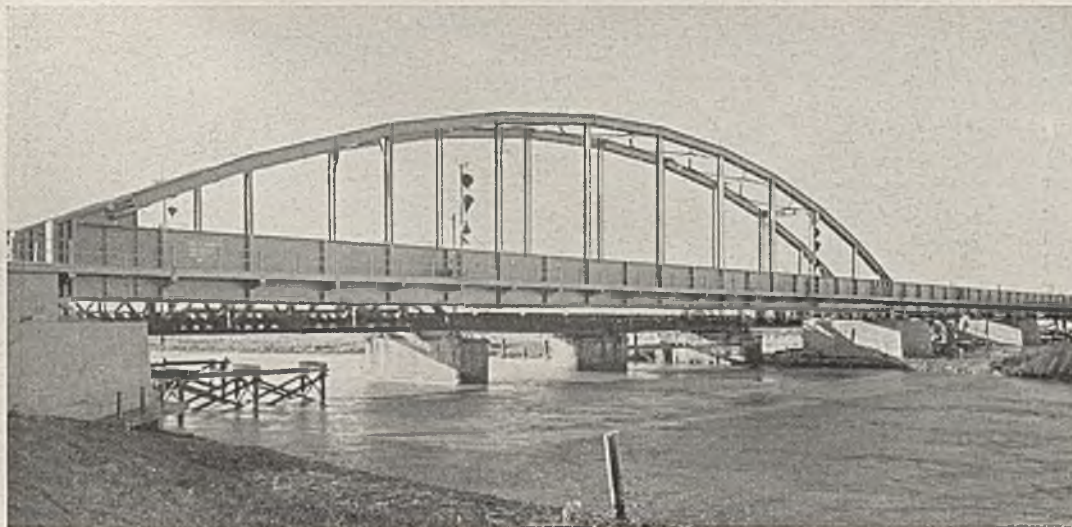
Abb. 2. Ostebrücke bei Hechthausen. Gesamtansicht.
