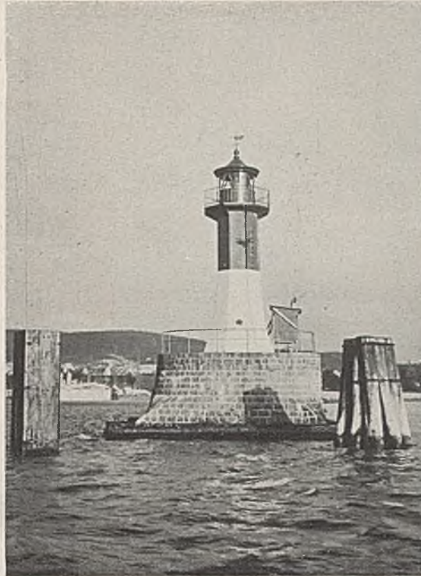
Abb. 2. Leuchfeuer Saßnitz nach Erneuerung des Unterbaues.
