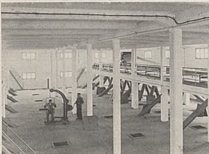
Abb. 11. Dachgeschoß über den Silozellen.
