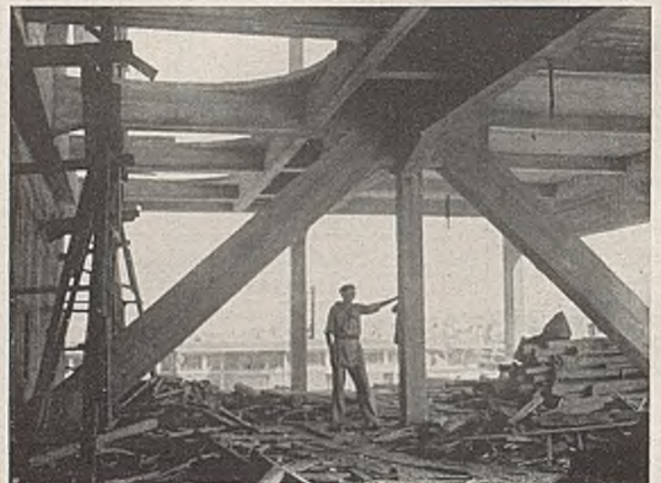
Abb. 12. Dreieckbinder im Anbau.
