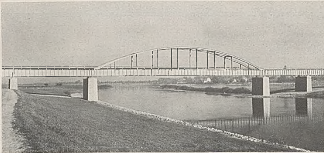
Abb. 7. Weserbrücke bei Porta. Stromüberbauten.
