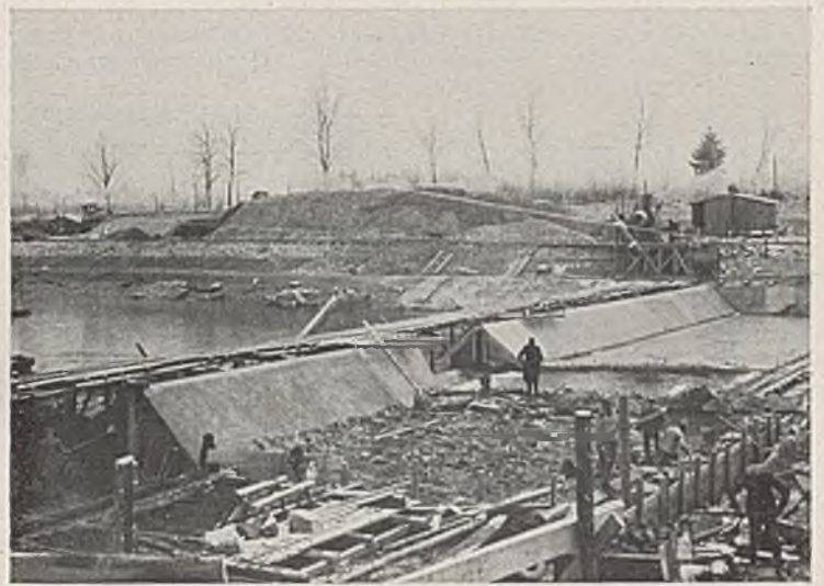
Abb. 2. Sohlschwelle bei Iller-km 36,93 im Bau.
