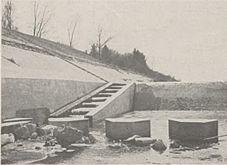
Abb. 3. Fischpaß und Zahnschwelle der Sohlschwelle bei Iller-km 36,93.
