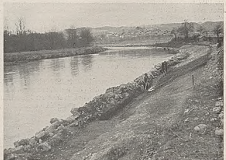
Abb. 8. Korrektionsbau bei Iller-km 100.
