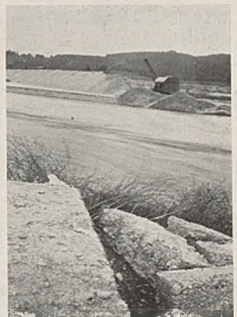
Abb. 13. Korrektion bei Lech-km 90,8. Herstellung eines Durchstiches.
