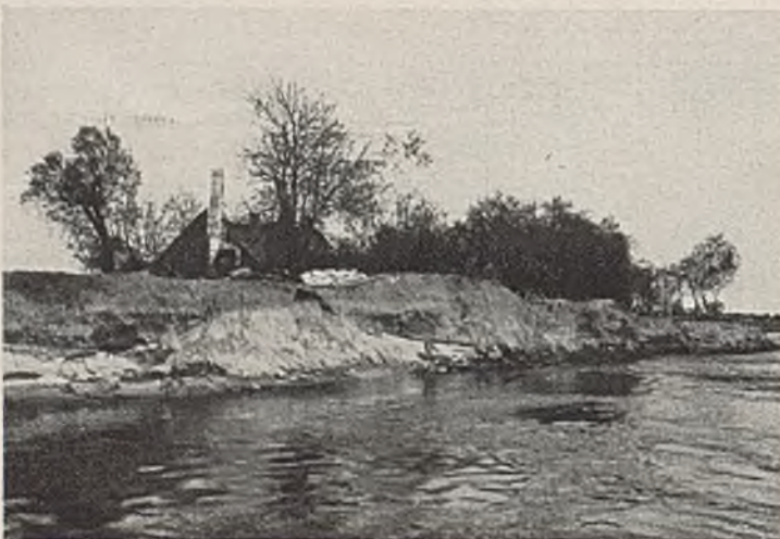
Abb. 1. Dorf Zabelcze durch Uferanbruch bedroht.
