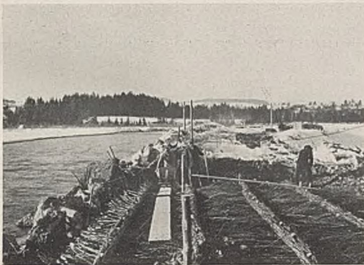
Abb 10. Baudurchbruch bei Lech-km 159,6. Einbau der Grundlage.
