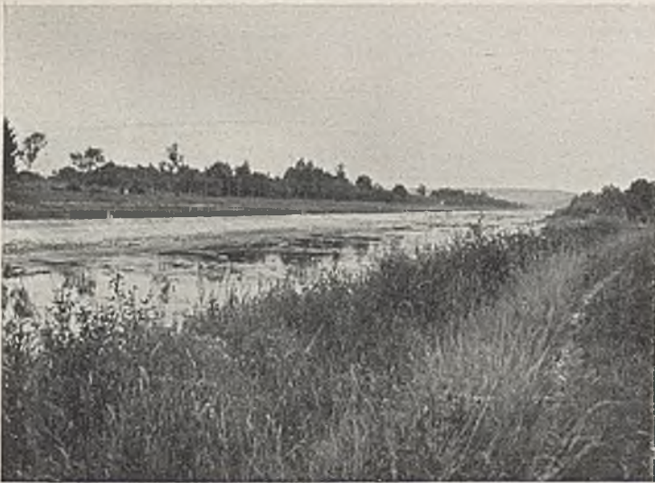
Abb. 1. Baustelle der Sohlschwelle bei Iller-km 36,93.
