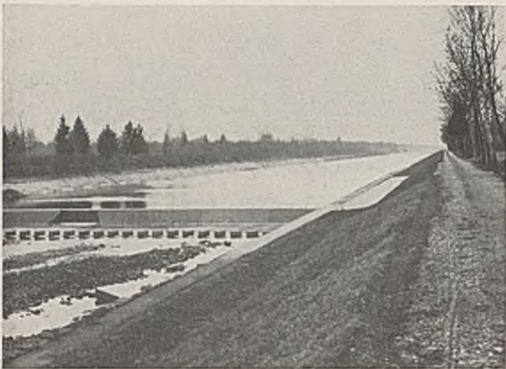
Abb. 5. Sohlschwelle bei Iller-km 36,93 eingestaut.
