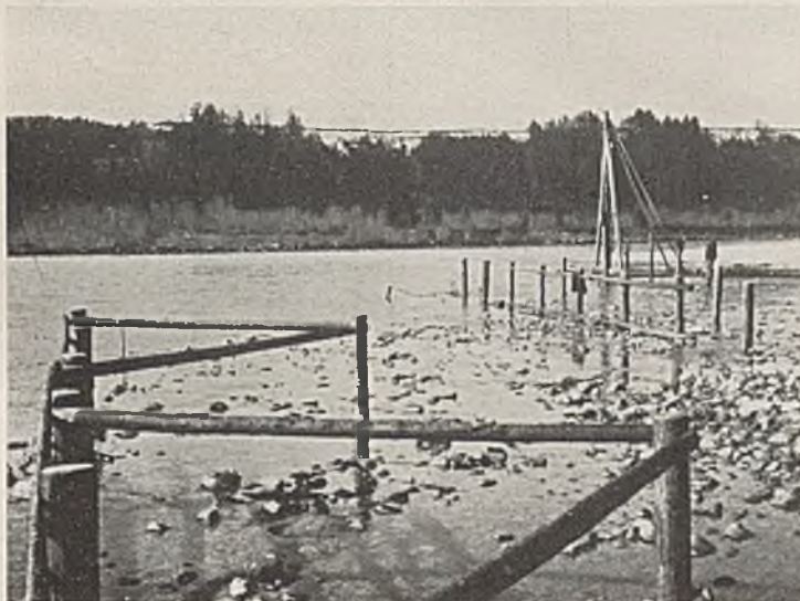
Abb. 12. Korrektion bei Lech-km 112,6. Gehängebau.
