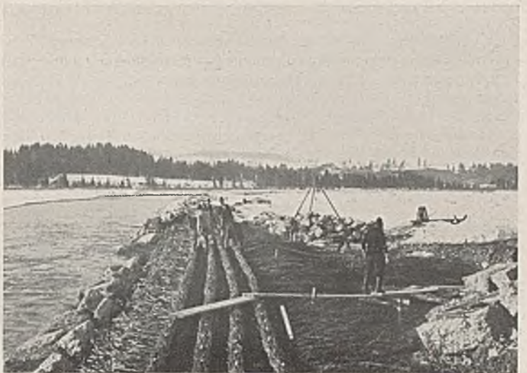
Abb. 11. Baudurchbruch bei Lech-km 159,6. Einbau der Faschinnenlagen.
