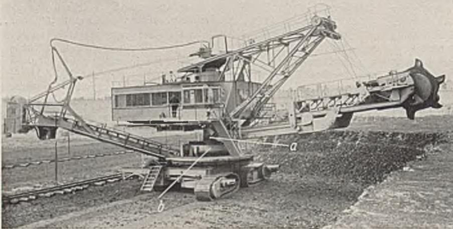
Schaufelradbagger mit Schwenksäule und Drehteller und ausziehbarem Schaufelradausleger.
