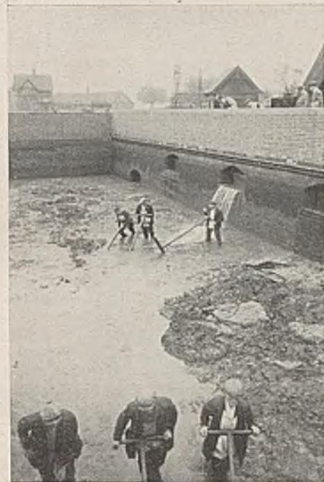
Abb. 11. Schlammausräumung von Hand, Kläranlage Saltley Works in Birmingham.
