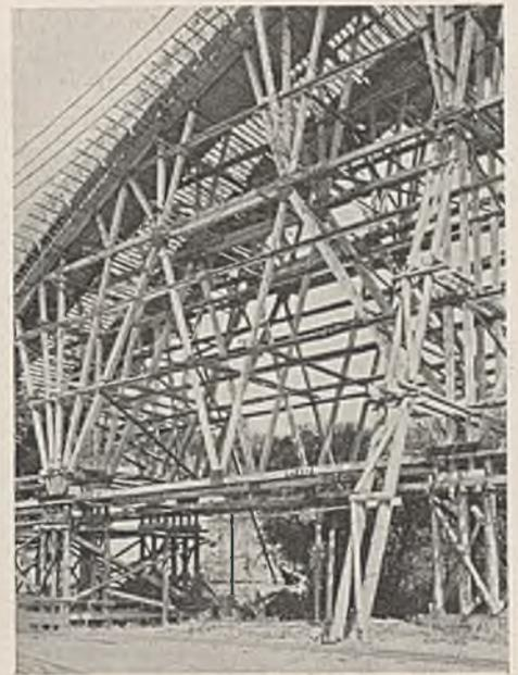
Abb. 18. M-förmiges Fachwerk.
