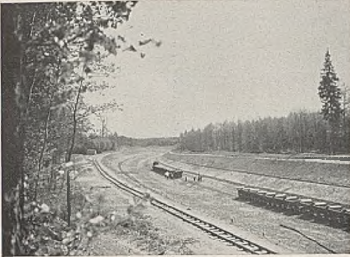
Abb. 3. Masurischer Kanal. Haltung Fürstenau (Oberschleuse)—Mauersee nahezu fertiggestellt.
