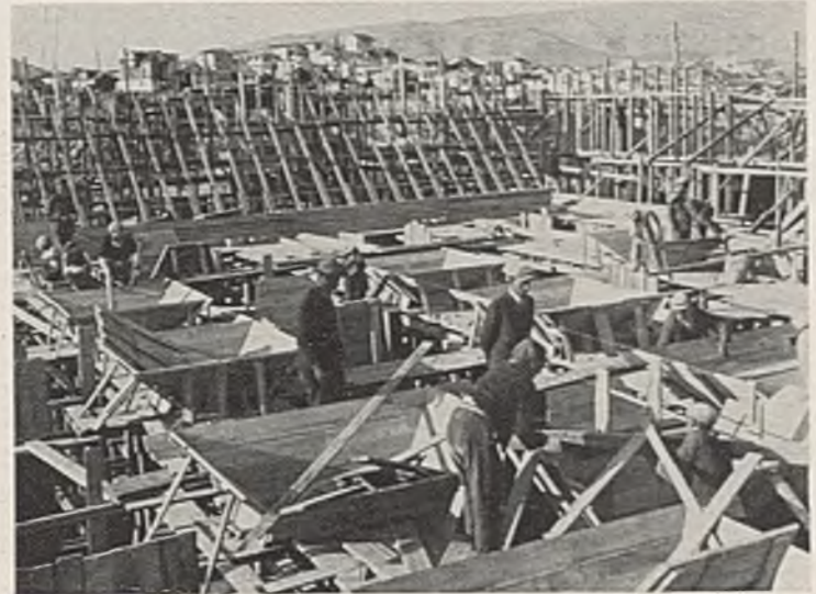
Abb. 22. Einschalen der Siloaufläufe.
