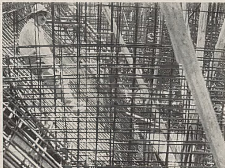
Abb. 18. Bewehrung einer Randzelle.
