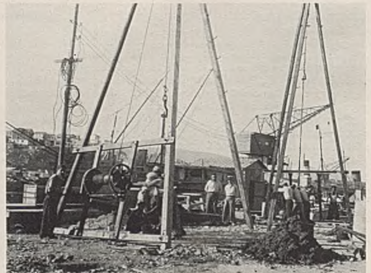
Abb. 21. Bohrböcke bei der Pfahlgründung.
