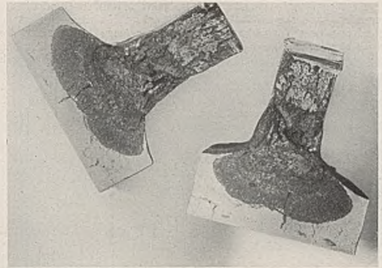
Abb. 12b. Nierenbrüche im Untergurt der Brücke am Bahnhof Zoo, Berlin.
