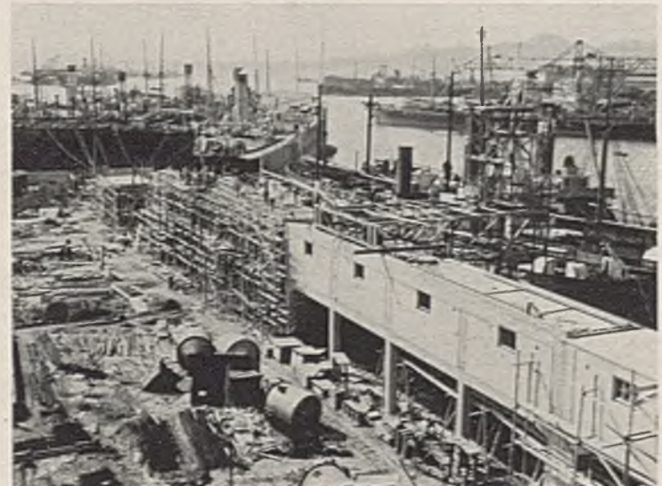
Abb. 25. Bau der Bandbrücke.
