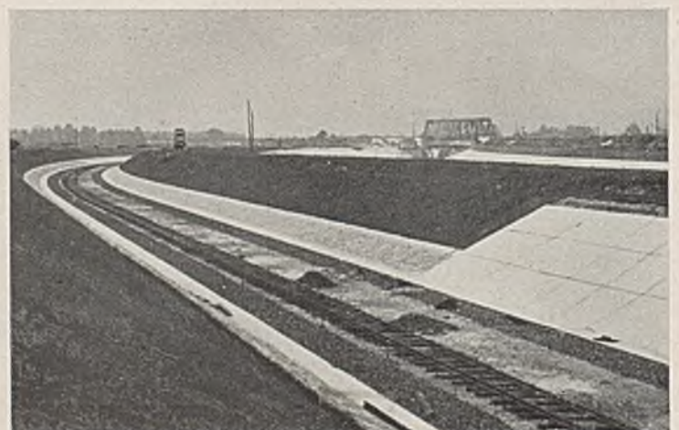
Abb. 12. Klodnitzverlegung bei Laband. Im Hintergrunde neue Eisenbahnbrücke über den Adolf-Hitler-Kanal.
