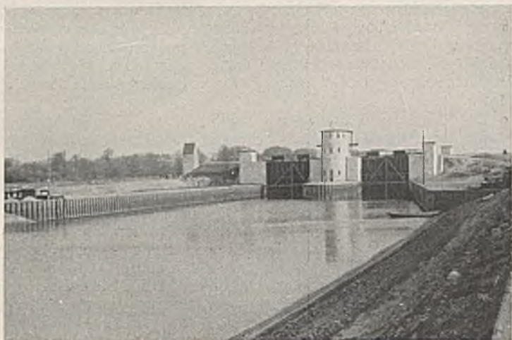
Abb. 15. Unterhafen und Unterhaupt der Schleuse Hubenland.
