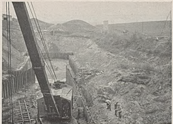
Abb. 7. Unterschleuse Fürstenau. Umschließungspundwände der Schleuse und Schleusenelfahrt fertig gerammt.
