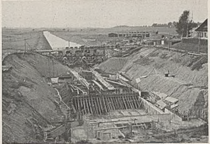
Abb. 4. Schachtschleuse Marschallsheide. Kammersohle zum Betonieren fertig eingeschalt. Dahinter die Betonbereitungsanlage (2 Pumpen und 4 Mischer).
