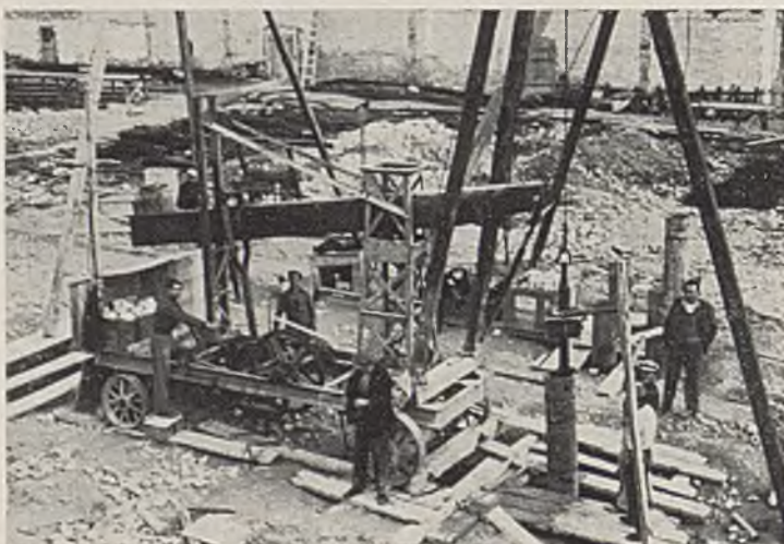
Abb. 20. Freifallbohrapparat für die Pfahlgründung.
