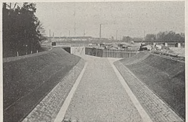
Abb. 10. Klodnitzverlegung bei Laband. Blick auf die Baugrubenumspundung des Hochwasser-Ablaßbauwerks.
