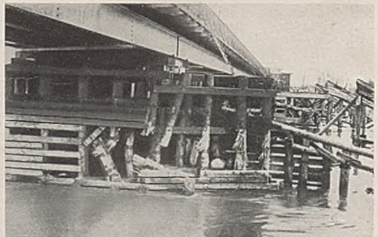
Abb. 9. Pfahljoch der Straßenbrücke bei Deblin. Eisgang 1917.
