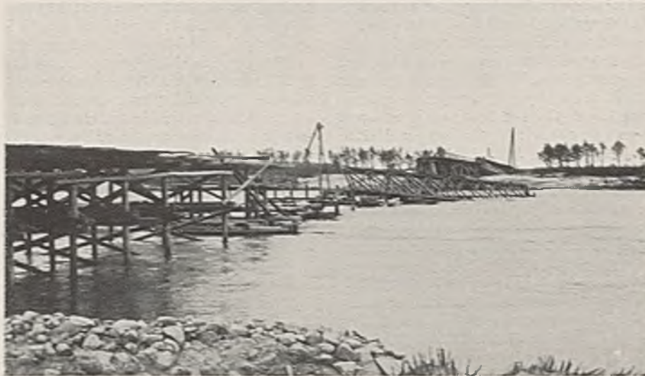
Abb. 10. Eisenbahnbrücke über den See bei Rozwadów. Eisgang 1917.
