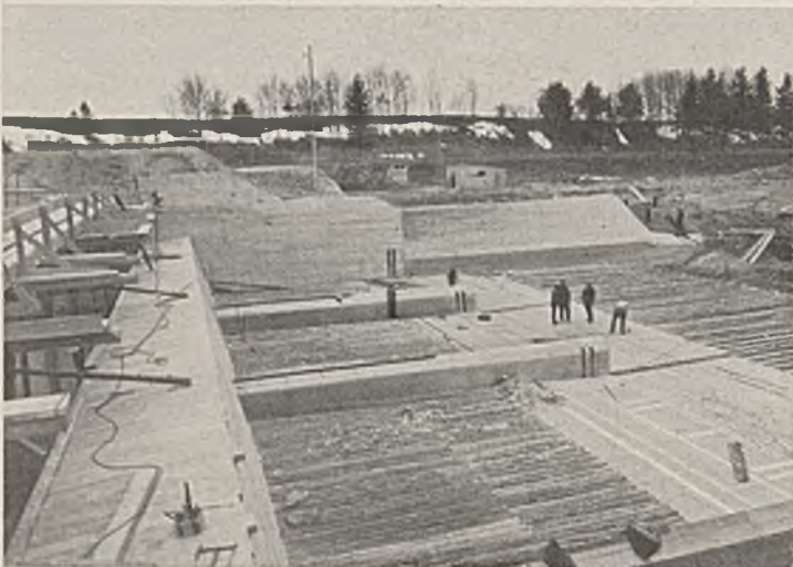
Abb. 17. Lechwehr bei Kaufering. Linke Wehrhälfte.
