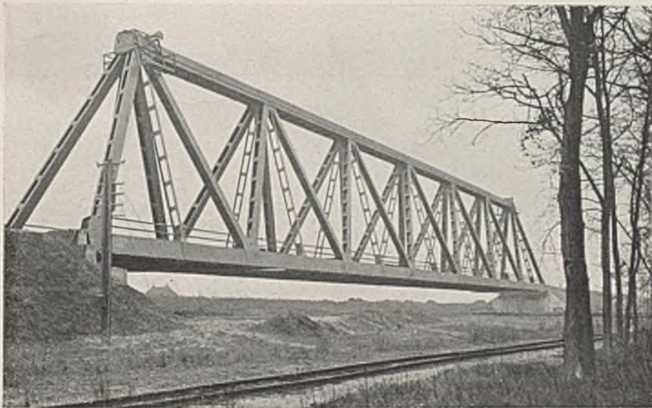
Abb. 16. Kanalbrücke bei Lüdinghausen. Gesamtansicht.
