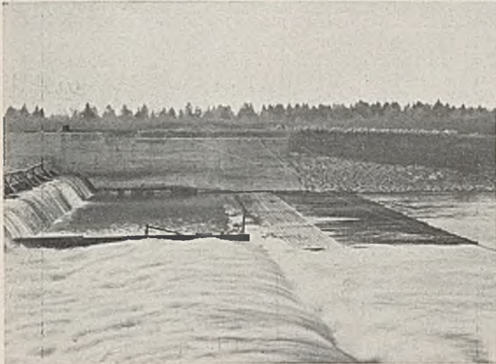
Abb. 19. Einbau einer Floßfeder im Lechwehr Arnold.
