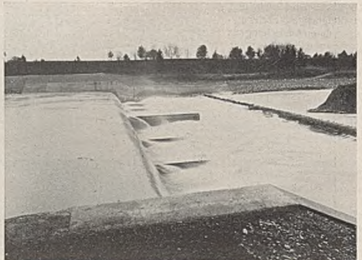
Abb. 18. Fertiges Lechwehr bei Kaufering.
