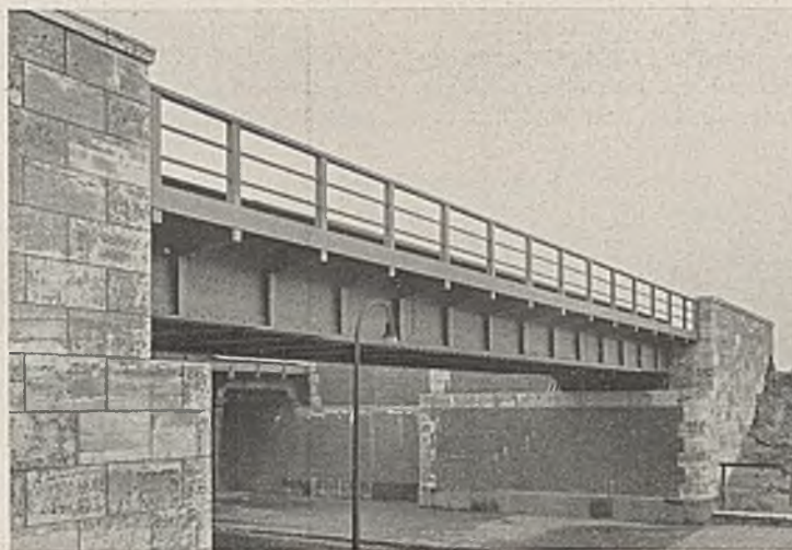
Abb. 24. Unterführung der Mackensenstraße unter der Güterumgehungsbahn Billwärder—Eidelstedt.
