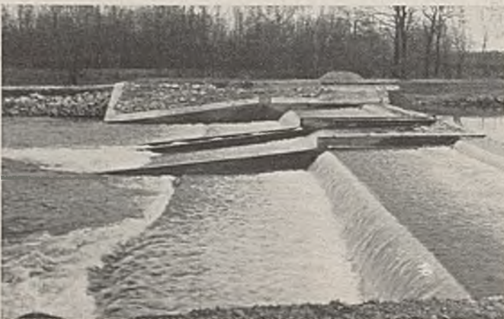
Abb. 22. Fertiges Wertachwehr bei Pforzen.
