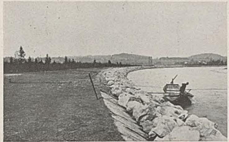
Abb. 19a. Nachverstocken einer früher durch eine verwilderte Lechstrecke geführte Korrektion, an deren Ufer der Auenwuchs sich gut entwickelte.
