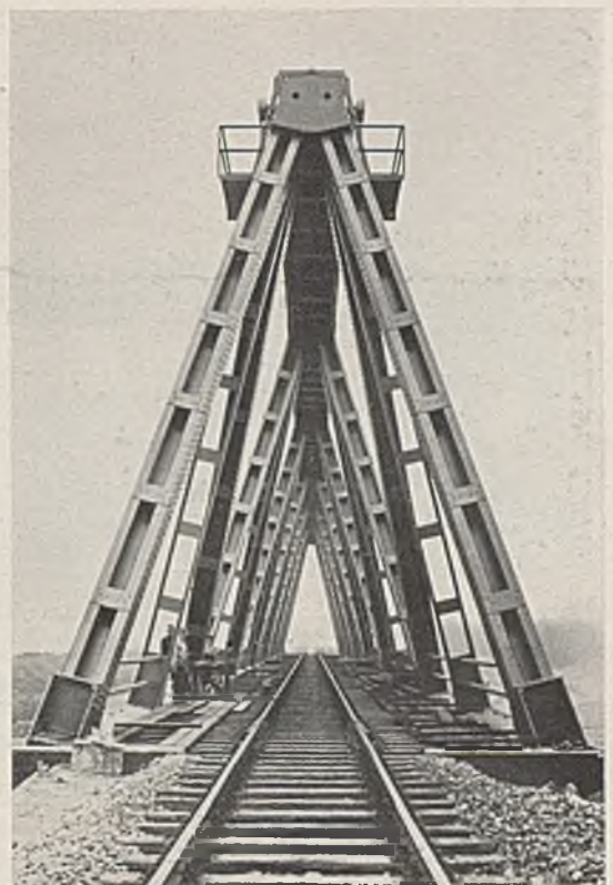
Abb. 17. Kanalbrücke bei Lüdinghausen. Durchblick.
