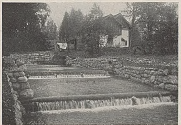
Abb. 24a. Durch eine Sperrengruppe an der Windbachlaine bei Oberammergau werden Siedlung und Wald vor Zerstörung geschützt.
