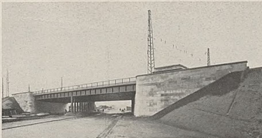
Abb. 25. Unterführung der Allersberger Straße unter der Strecke Nürnberg-Dutzendteich—Nürnberg-Rangierbahnhof.
