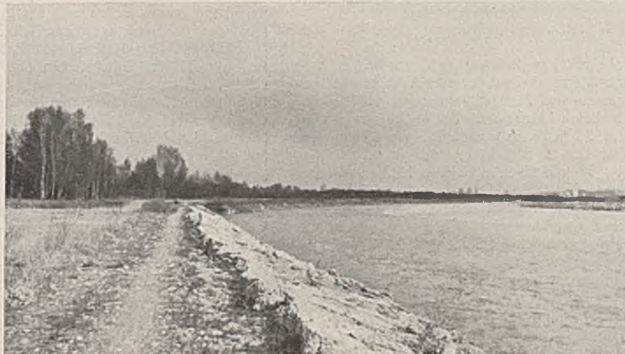
Abb. 19b. Neues Leitwerk durch eine verwüstete Lechstrecke; im Hintergrunde älteres Leitwerk, hinter dem sich hoher Auenstand entwickeln konnte.
