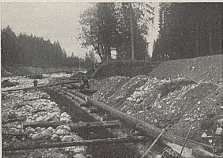
Abb. 23a. Schutz von Forst, Straße und Wald im Lindergries durch hölzerne Uferschutzbauten.
