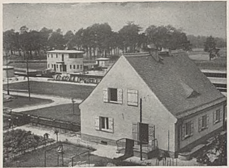
Abb. 26. Dienstgehöft an der Schleuse Ehrenforst.
