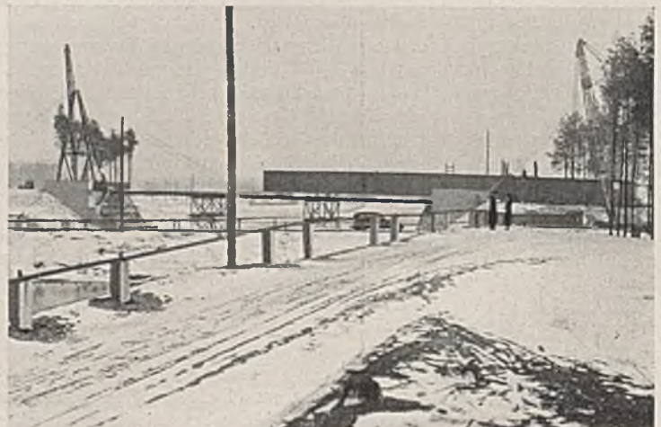
Abb. 18. Straßenbrücke Waldbrücken. Überschieben der Hauptträger.
