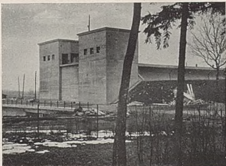
Abb. 23. Schleuse Georgenfelde (Masurischer Kanal).
