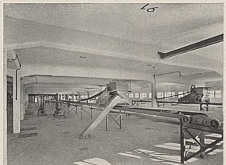
Abb. 3. Blick in das Dachgeschoß mit den drei Förderbändern.
