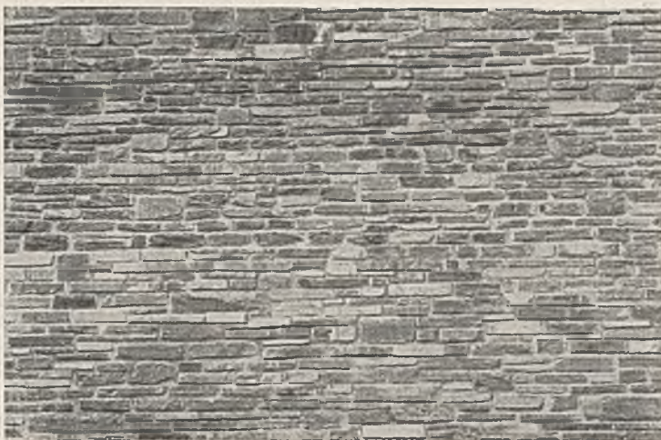
Abb. 8. Kopfsteinmauerwerk aus Theumaer Schiefer.
