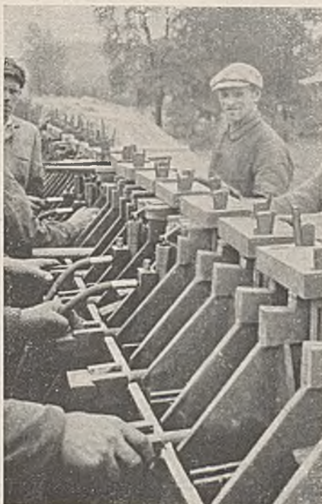
Abb. 16. Spannen und Festkeilen der Bügel an der Obergurtform.
