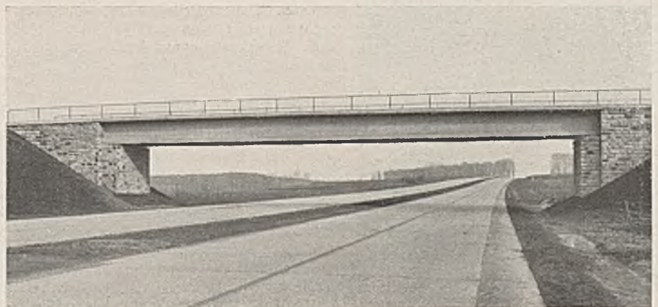
Abb. 20. Gesamtansicht der fertigen Spannbetonbrücke System Freyssinet-Wayss & Freytag.
