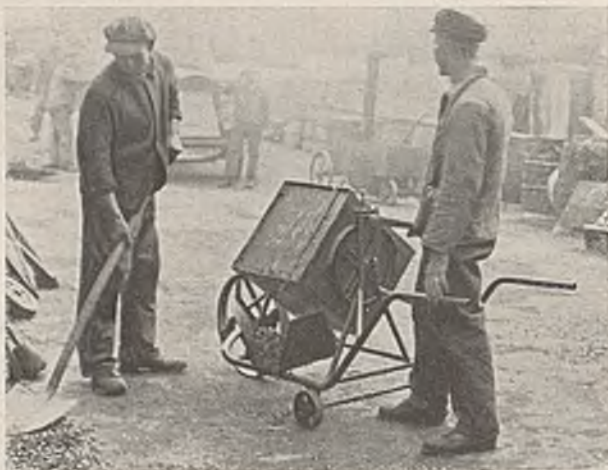
Abb. 4. Kastenförmiger Handmischer für Ausbesserungen mit Teersplitt und -sand.
