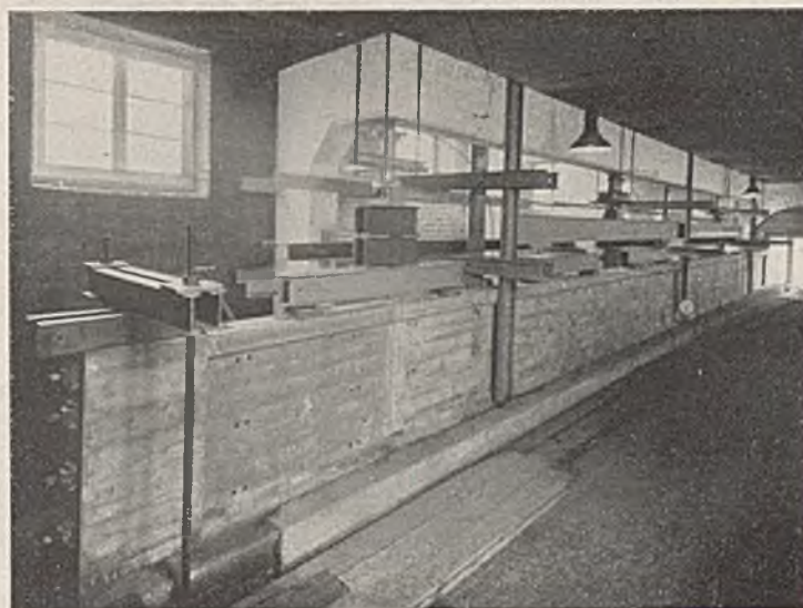
Abb. 4. Fertiger Träger mit abgesenkter Wanne.
