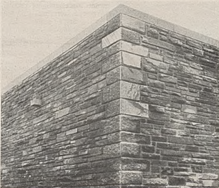
Abb. 9. Das Mauerwerk an der vorspringenden Ecke des Parkplatzes.
