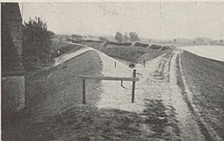
Abb. 35. Deichverlegung bei Stehla.
