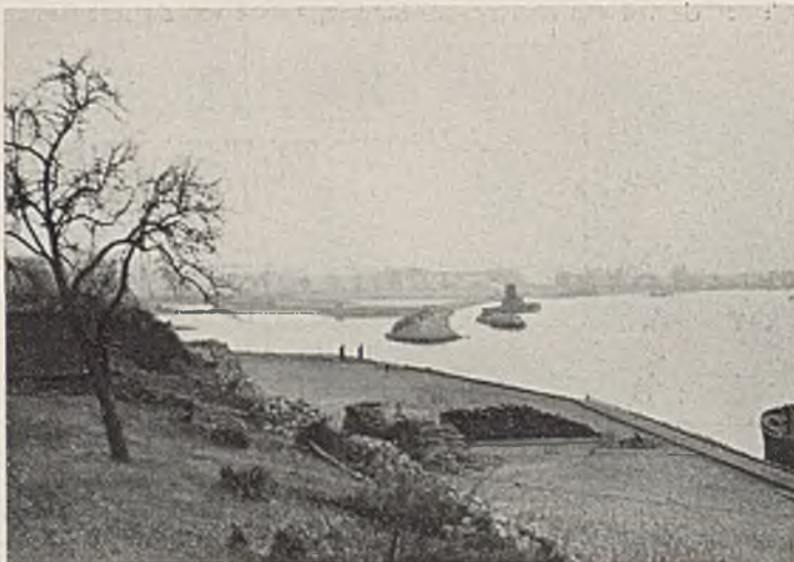
Abb. 38. Leitwerk mit Leitwerkfeldern in der Ausbaustrecke Dornburg.
