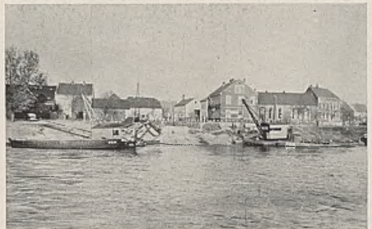
Abb. 36. Bau der Fährbuhne (Elster—Gallin).
