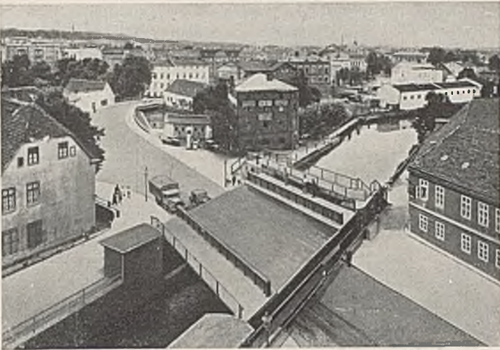
Abb. 33. Hubbrücke über den Finowkanal in Eberswalde.
