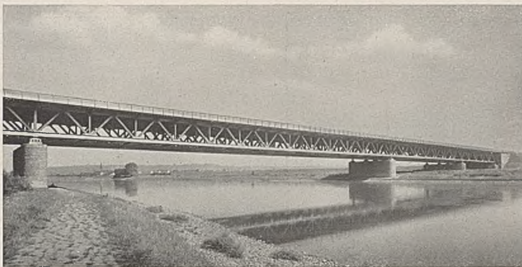
Abb. 1. Reichsautobahnbrücke über die Elbe bei Dresden.
