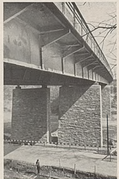
Abb. 36. Brücke über das Lützelbachtal. Konsolansicht.
