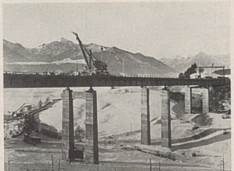
Abb. 20. Talübergang Bergen während der Montage.
