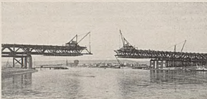
Abb. 5. Elbebrücke bei Dresden. Freivorbau.
