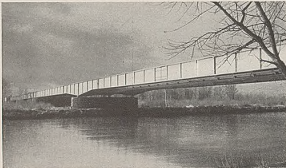
Abb. 14. Donaubrücke bei Ingolstadt.
