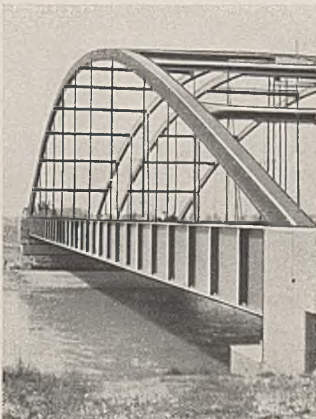
Abb. 46. Lechbrücke bei Augsburg.
