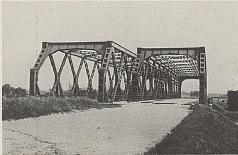
Abb. 16. Brücke über den Dortmund-Ems-Kanal.
