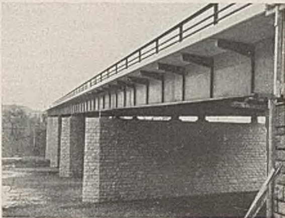
Abb. 45. Brücke über die Glauchauer Mulde. Konsolansicht.
