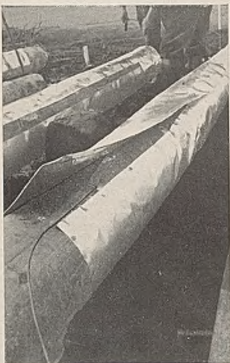
Abb. 5. Vorbereitung der Alupfähle.
