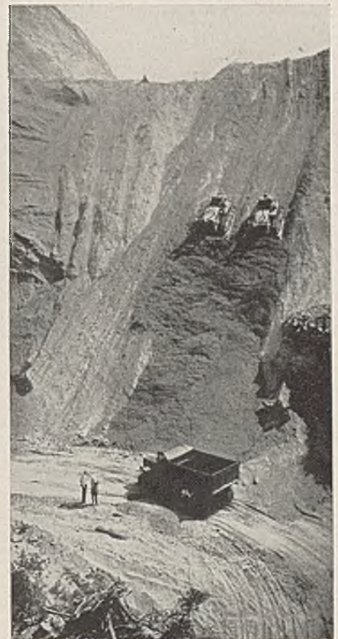
Abb. 12. Einschnittarbeiten zur Beseitigung eines Straßentunnels in Kalifornien. Aus California Highways and Public Works, November 1938.
