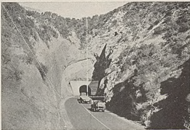
Abb. 11. Straßentunnel in Kalifornien. Aus California Highways and Public Works, November 1938.
