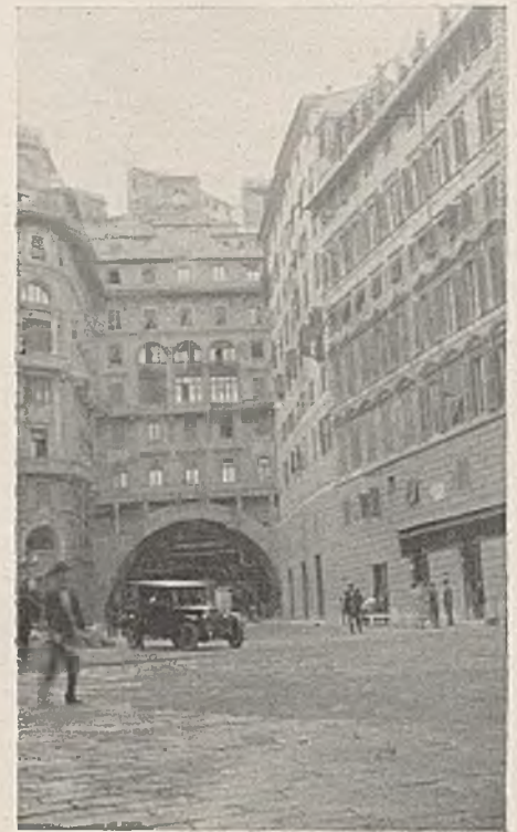
Abb. 7. Genua. Vitt. Emanuel III.-Tunnel. 275 m lang, 15 m breit.
