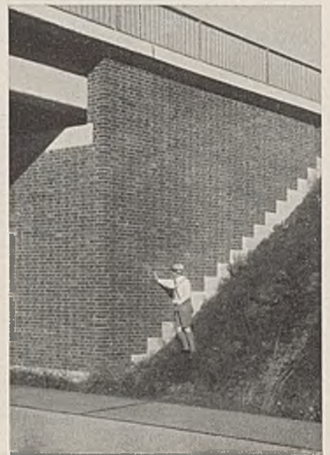
Abb. 13. Widerlager einer Überführung. Der schwarze Strich im Gesimse ist die Fuge zwischen Überbau und Widerlager. Die Lager liegen unter den Balken rückwärts im Schalten.
