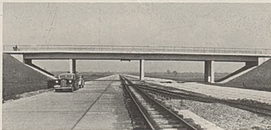
Abb. 4. Straßenüberführung, Plattenbalken.
