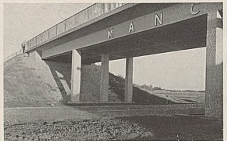
Abb. 5. Straßenüberführung. Schräge Untersicht. Die Sichtflächen sind fein gespült.
