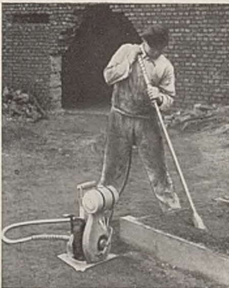
Abb. 8. Schwingungsrüttler mit Antrieb durch einen Benzinmotor. Aufnahme: Losenhausenwerk AG.
