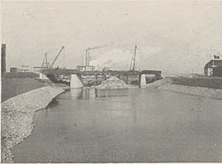
Abb. 42. Verbindungskanal bei Magdeburg-Rothensee mit im Bau begriffener Straßen- und Hafenhafenbrücke.
