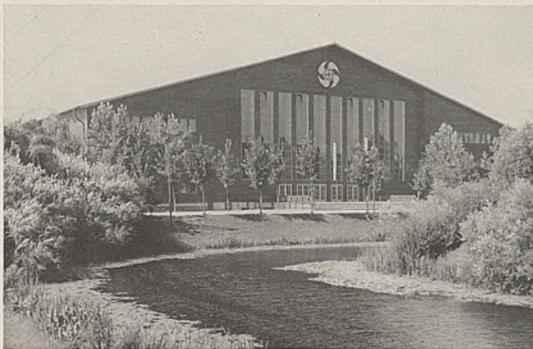
Abb. 4. Giebelansicht der Halle.
