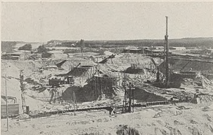
Abb. 50. Doppelhebewerk Hohenwarthe. Trogkammerbaugrube mit den vier Schächten. Die Gefrierrohre sind zum Teil freigelegt.
