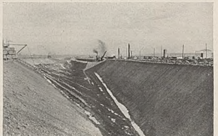
Abb. 46. Aushub des Hafens am Stichkanal bei Hallendorf.
