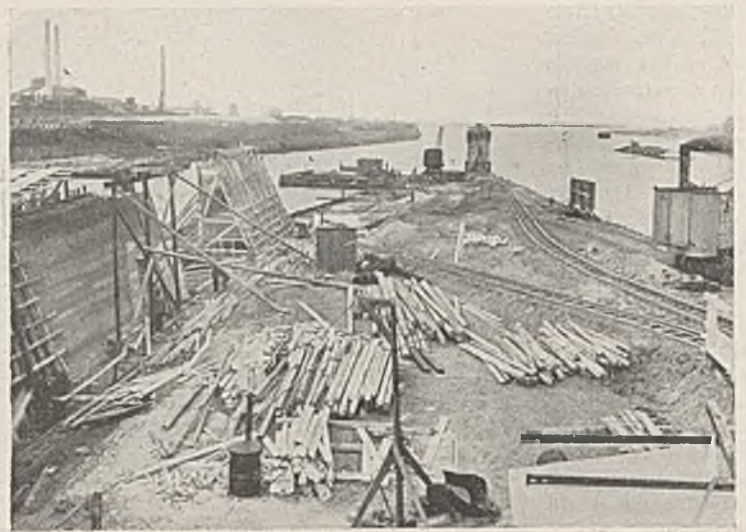
Abb. 43. Staustufe Magdeburg. Herstellung der Betonblöcke für die untere Mole des Schleusenkanals.
