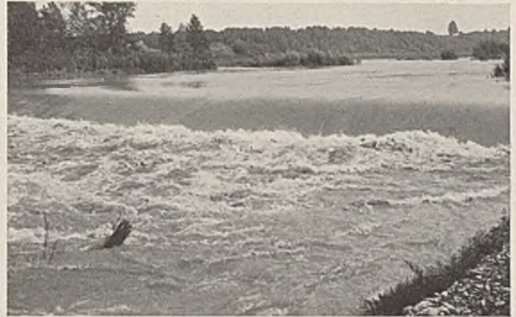
Abb. 46. Querbau in der Hinterrinne bei Inn-km 21,7.
