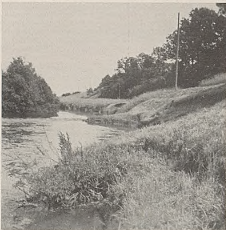
Abb. 56. Uferabbrüche an der Fränk. Saale bei Hammelburg.
