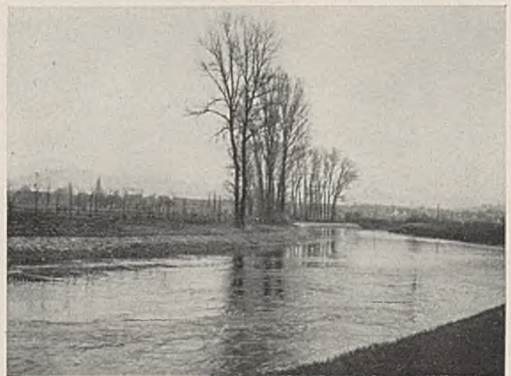
Abb. 53a. Durch die Korrektur am Main bei Ebensfeld wird vorhandenes Kulturland vor Abbruch und Verwüstung geschützt.
