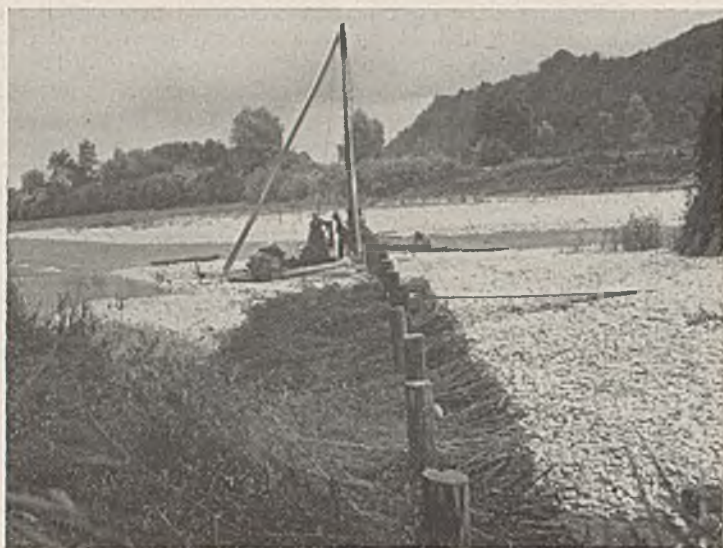
Abb. 48. Gehängebau bei Alz-km 29,8.
