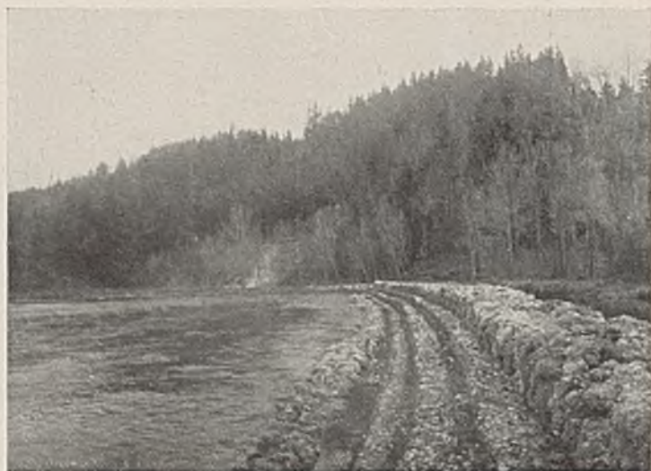
Abb. 49a. Mit einem Leitwerk an der Alz wird ein durch Uferabrüche in Bewegung geratener Hang mit Waldbestand gesichert.
