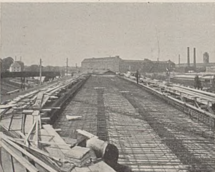
Abb. 12. Bewehrung des Überbaus.
