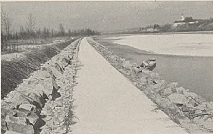
Abb. 45. Verstärkter und erhöhter Korrektionsbau bei Inn-km 22.
