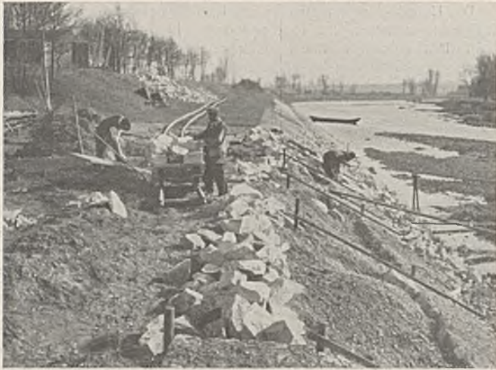
Abb. 54. Uferdeckwerk an der Regnitz bei Hirschaid.
