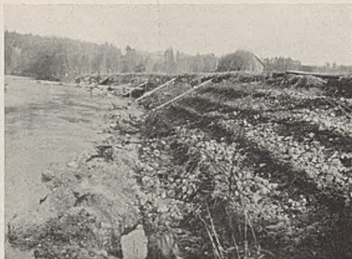
Abb. 50. Herstellung von Berauhwehung bei Traun-km 19,5.
