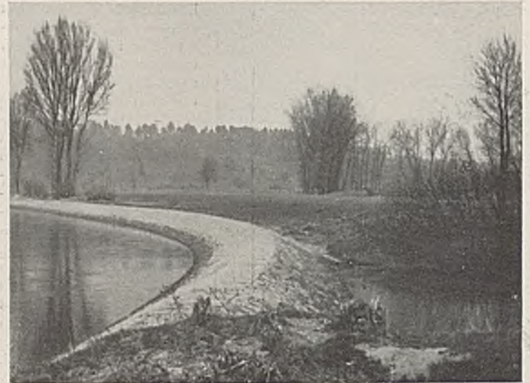
Abb. 55. Leitwerkbau an der Regnitz bei Bug.
