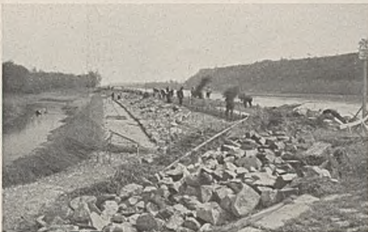
Abb. 47. Verstärkung des Korrektionsbaues bei Inn-km 34,3.
