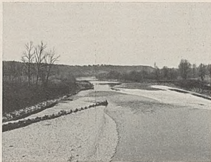
Abb. 49. Gehängebau bei Alz-km 29,8.
