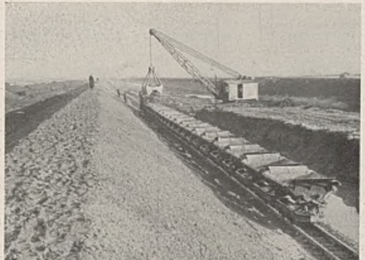
Abb. 61. Rücklaufdamm an der Laber (Straubinger Becken).
