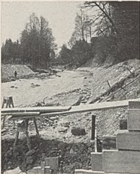
Abb. 51. Korrektur der Prien. Blick von der Sperrenbaustelle flussaufwärts.
