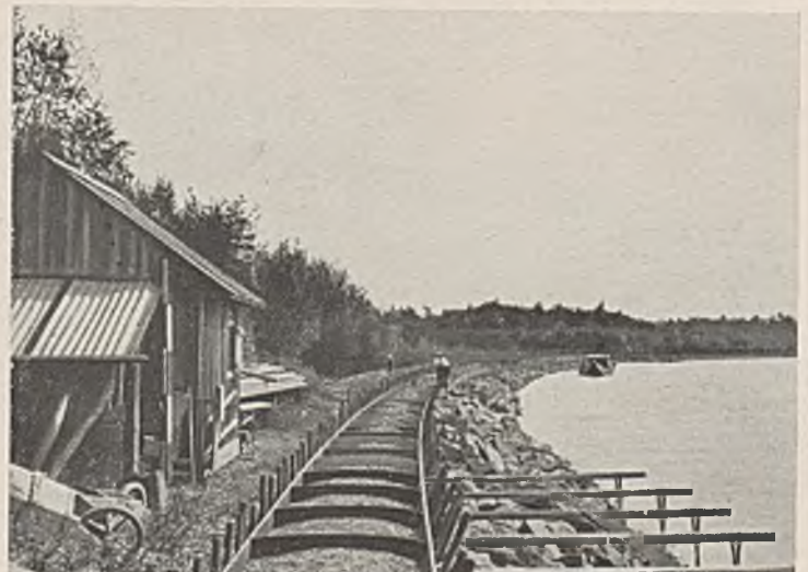
Abb. 47a. Durch einen Leitwerkbau am Inn wird den starken Angriffen des Flusses auf den vorhandenen Wald Einhalt geboten.
