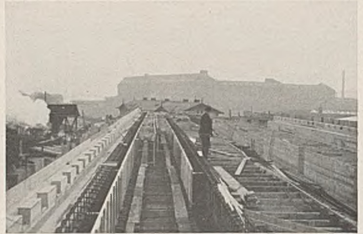
Abb. 11. Einschalung des Überbaus.
