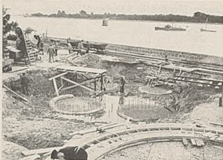
Abb. 9. Die Brunnen sind abgesenkt. Vorn die hölzernen Ringe für die Gleitschalung. 5. September 1936.
