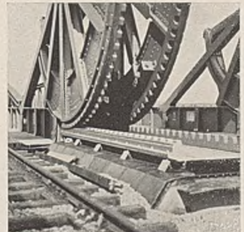
Abb. 8. Rollkranz- und Rollbahnverzahnung.
