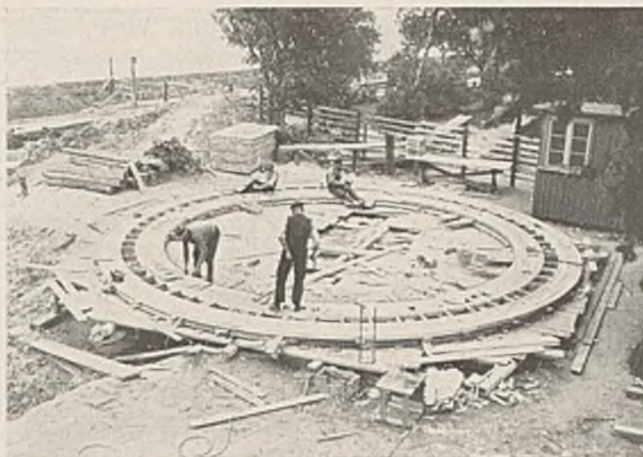
Abb. 10. Hölzerne Ringe für die Gleitschalung. 5. September 1936.
