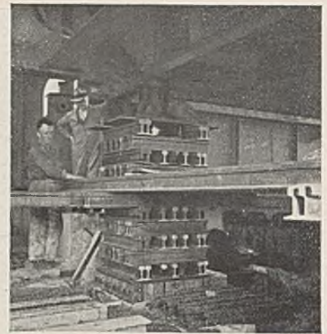
Abb. 10. Kellerüberbrückung auf stählernen Absenkstapeln, um die Brücke nach dem Einschleiben um 2,2 m absenken zu können.
