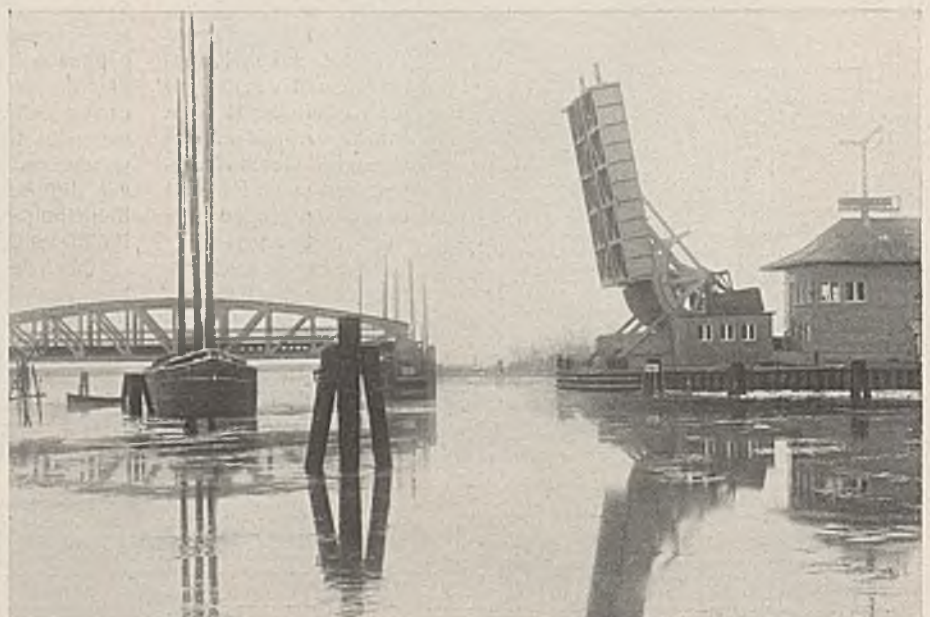
Abb. 4. Geöffnete Brücke von Oberstrom.
