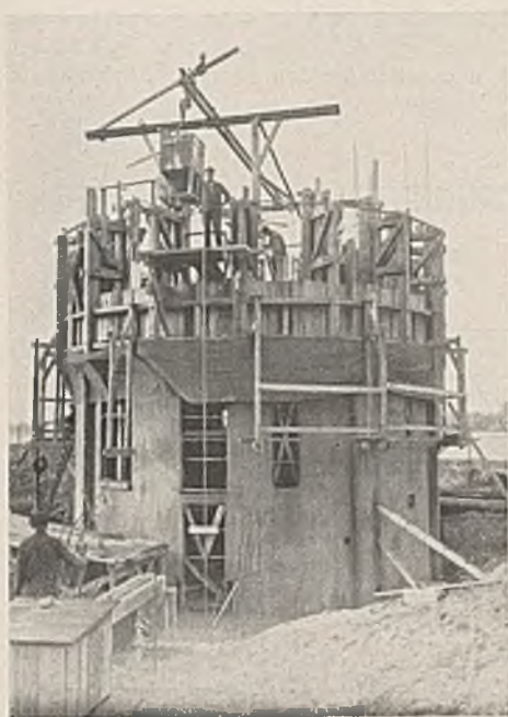
Abb. 11. Bauzustand des Gleitbaues zu Beginn des dritten Tages. 17. September 1936 um 7 45 Uhr.
