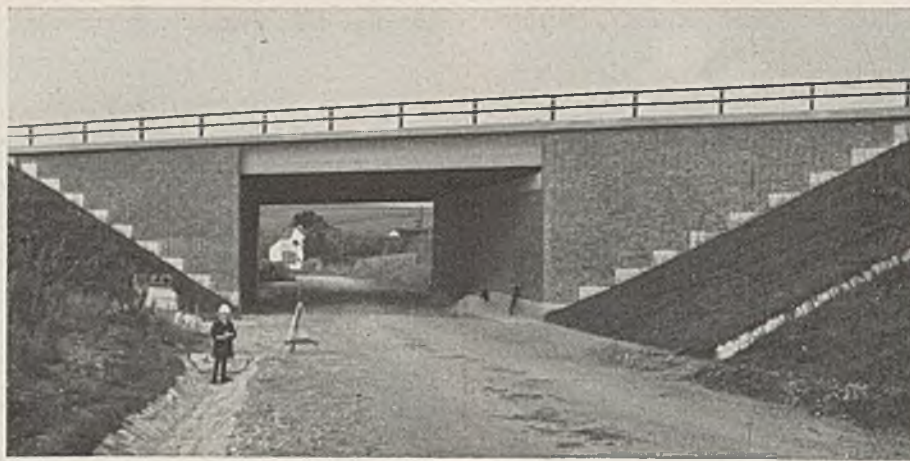
Abb. 15. Straßenunterführung — Plattenbalken — mit Betonaullagerbank und Betonsockeln.
