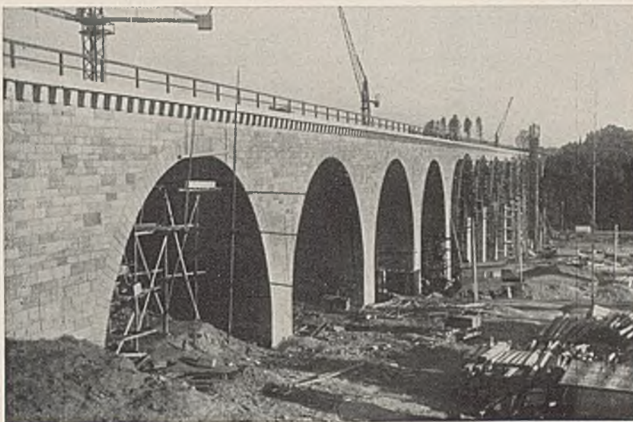
Abb. 41. Hölledaubrücke. Vom Nordwiderlager aus.
