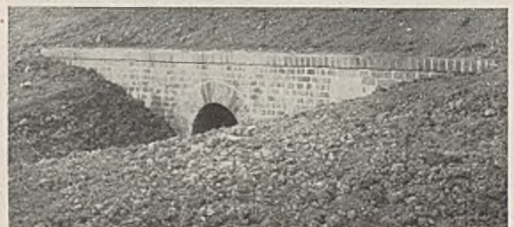
Abb. 20. Ausmündung eines Rohrdurchlasses. Die Stirnmuer ist mit einer Ziegelrollschicht abgedeckt.
