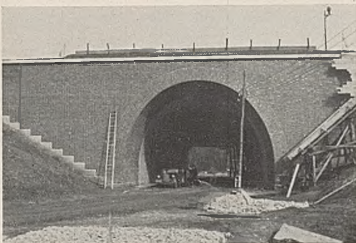
Abb. 35. Gewölbe im Ottergraben. Ansicht vor der Einfüllung.
