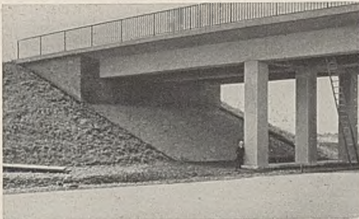
Abb. 14. Straßenüberführung — Vierfeldbrücke — mit ziegelverkleideten Widerlagern.
