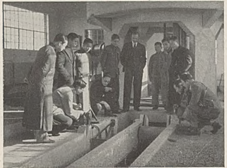
Abb. 8. Arbeiten am Segmentwehr und am Walzenwehr.
