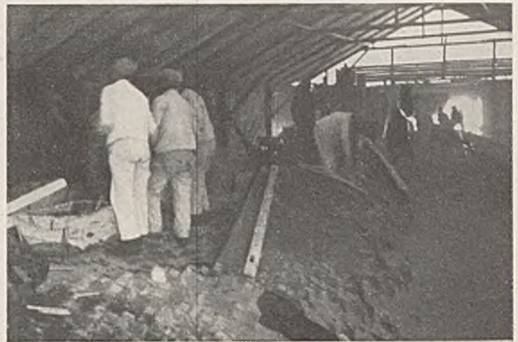
Abb. 33. Beim Mauern der schiefen Gewölbe der Glonnbrücke. Die Schichten steigen schraubenartig zum Scheitel hinauf und fallen jenseits zum Kämpfer hinab.
