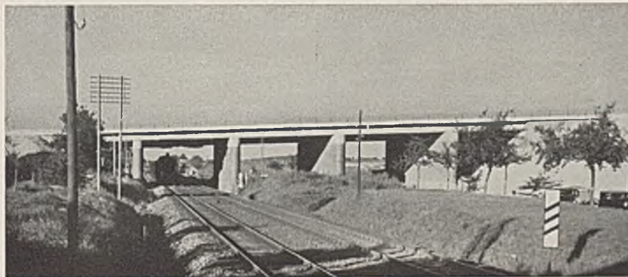
Abb. 23. 5-Feld-Brücke über eine zweigleisige Bahn und eine Straße am Bratzhof bei Wolnzach.
