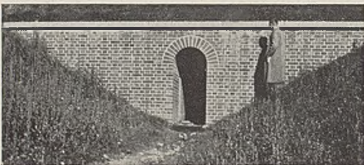
Abb. 19. Begehbare gewölbte Durchlaß.
