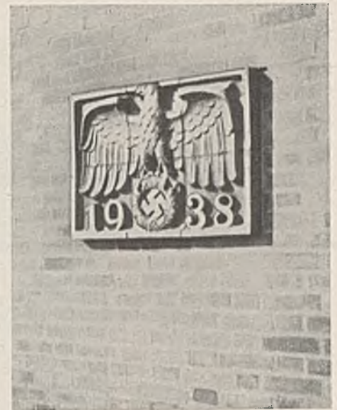
Abb. 37. Hoheitszeichen in Klinker. Probeausführung.
